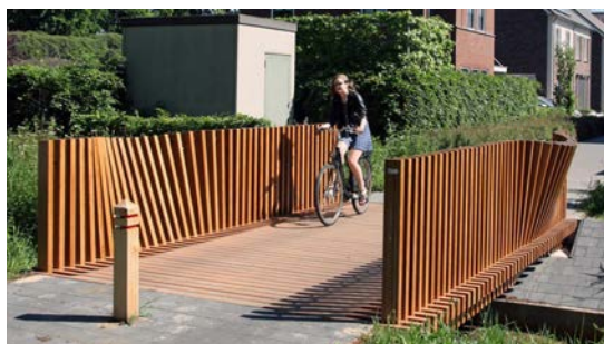
Vluchtroute voorzien van houtover de bestaande watergang richting de ventweg
