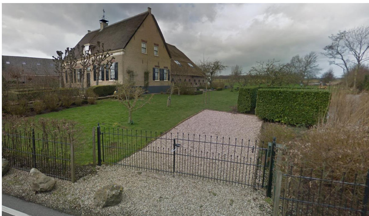
Afbeelding 3: Plangebied gezien vanaf het zuidoosten van de Bovenberg (bron: Google Maps)
