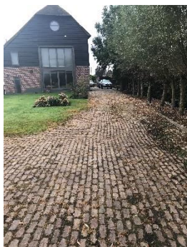
Foto F1: woonboerderij met oprit (richting zuiden)
