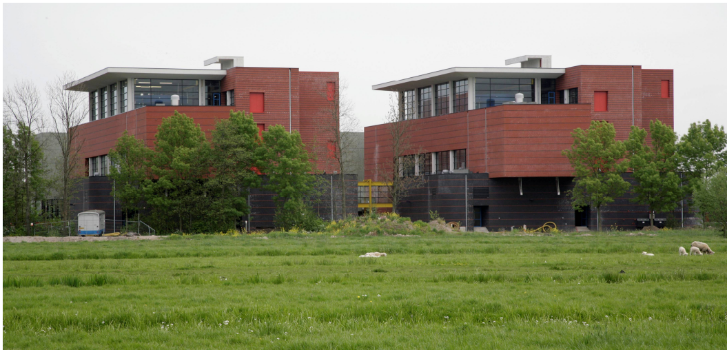
Zuiveringsstation Rodenhuis tegenover het plangebied (bron: Oasen)
