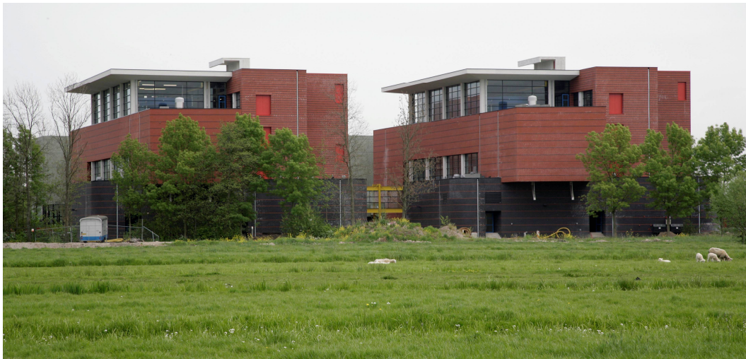
Zuiveringsstation Rodenhuis tegenover het plangebied (bron: Oasen)
