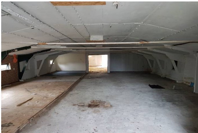
Foto 3: voormalige kippenstal in pandig, noordelijk gedeelte
