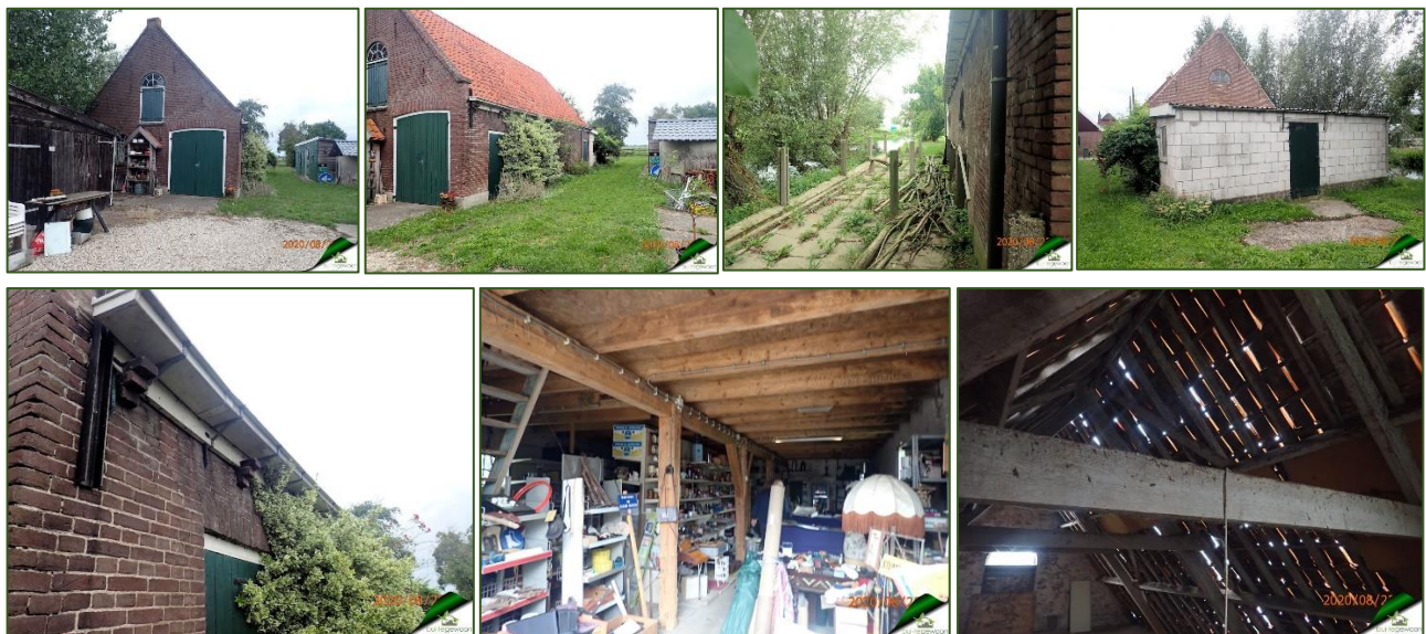
Figuur 7. Foto impressie te verbouwen opstal (bovenste rij van links naar rechts voorzijde, oost, west, achterzijde) (onderste rij van links naar rechts gootafdeling, inwendig benedenverdieping, dakconstructie vanaf zolder)
