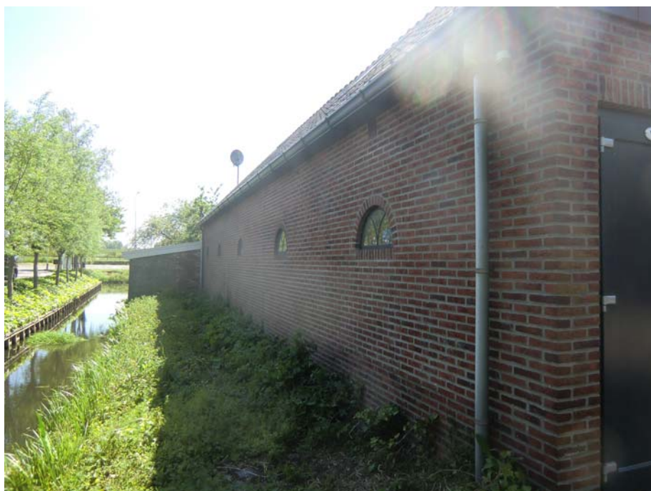
In de rechter zijgevel aan de slootzijde zijn de stalramen uit de oude stal hergebruikt zodat deze gevel daardoor een uitstraling heeft die overeenkomt met de oorspronkelijke schuur.
