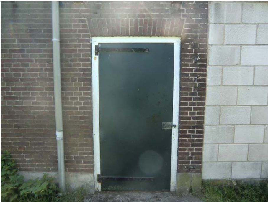
De achterste staldeur is vervangen door een vlakke deur van multiplex met modern hang- en sluitwerk.
