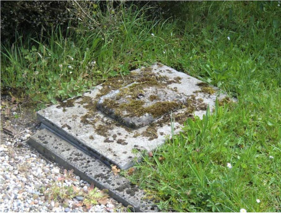
Foto van de put van de watermeter in de voortuin. Op en rond het erf zijn verder meerdere bio-tanks aanwezig. De aansluiting op de gemeentelijke riolering kwam eind jaren '70 tot stand.
