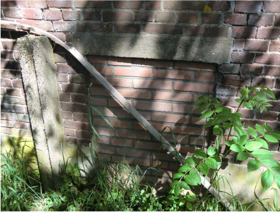
Detail van één van de dichtgemetselde varkensuitloopjes.
