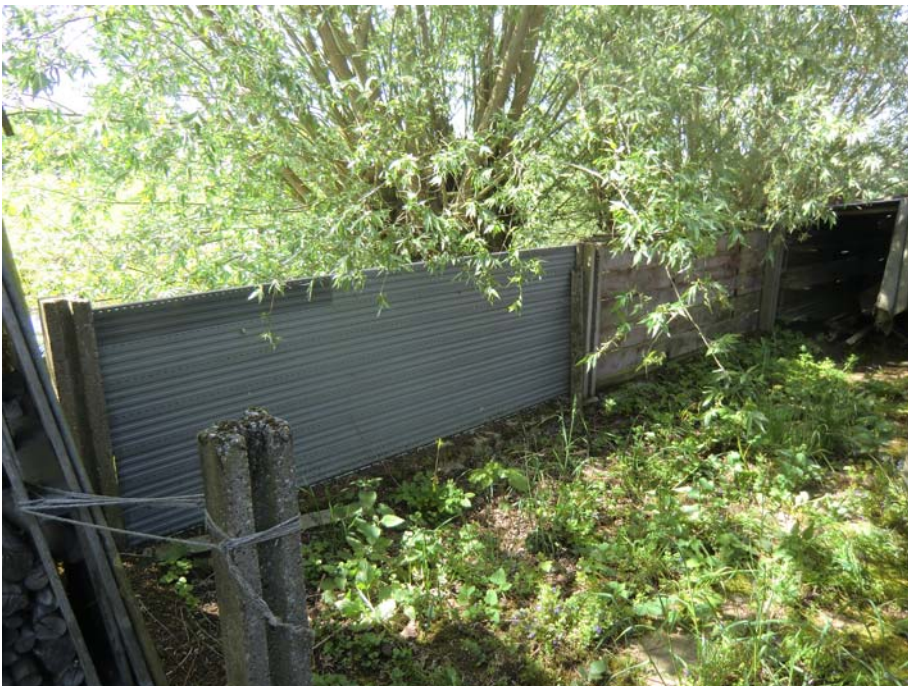
De voormalige varkensuitloop aan de linkerkant van de wagenschuur. Alle paaltjes zijn voorzien van gleuven, waar houten schotten, zoals tussen de achterste paaltjes, tussen gezet konden worden.
