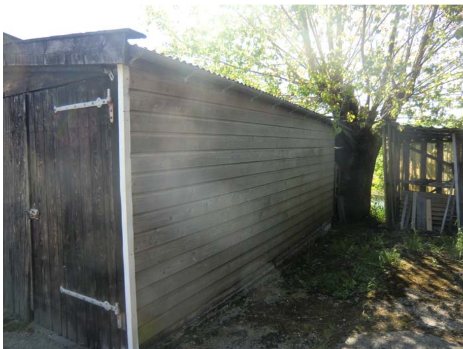
Achtergevel van de schuur.
