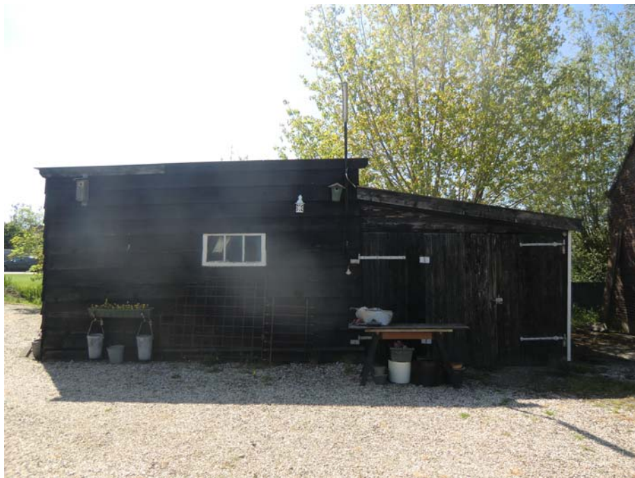
Oostgevel van de gereedschaps-schuur.
