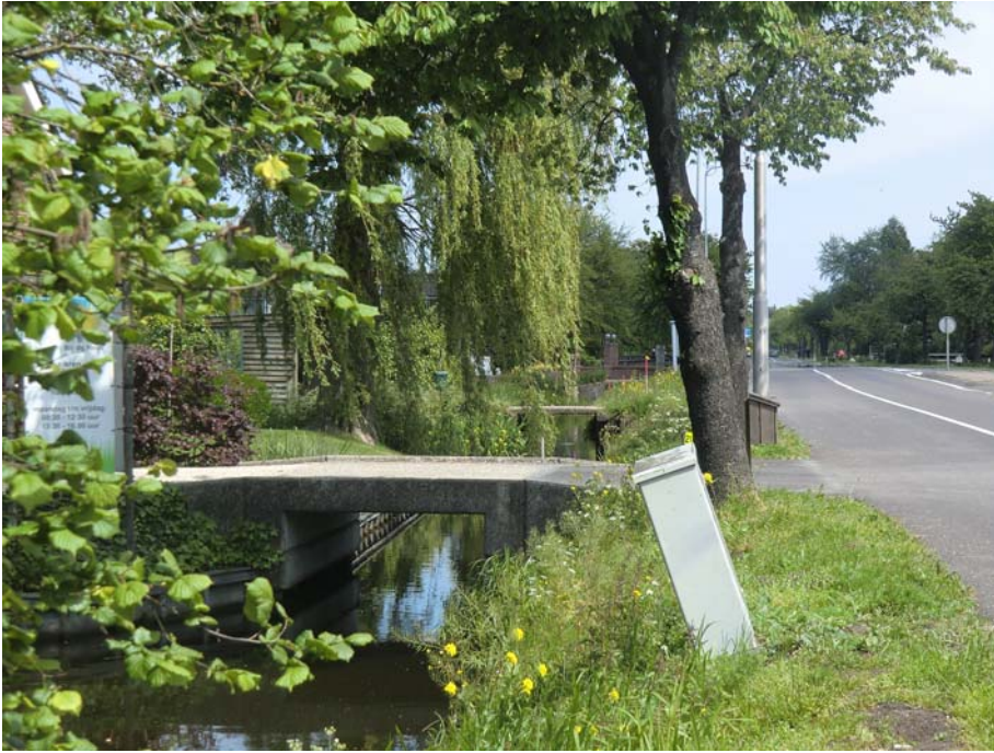
De Buitenwetering richting Schoonhoven.
