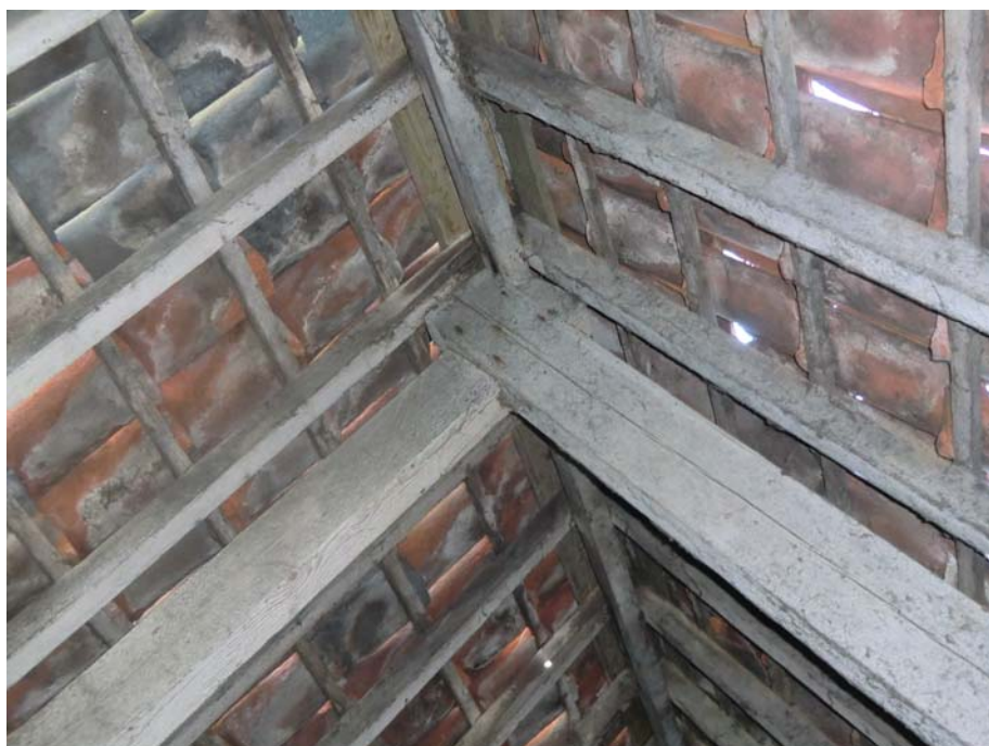
De kap is onbeschoten en bestaat uit gordingen, sporen, en panlatten.
