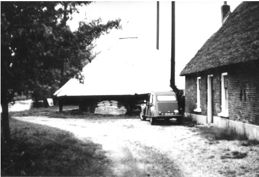
Linkerzijgevel boerderij en hooiberg.
