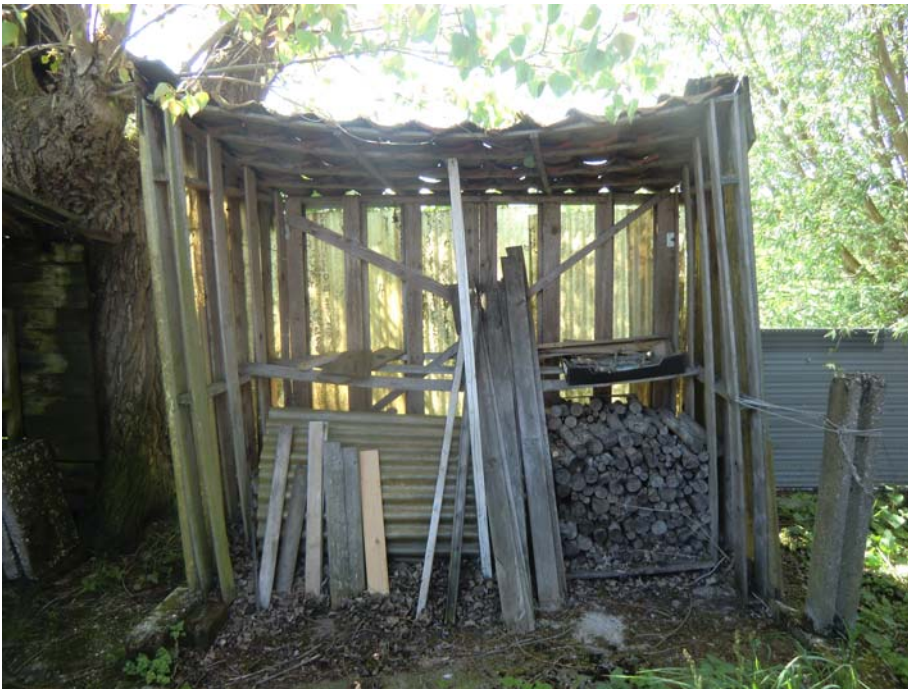
Bouwsel van sloophout, golfplaat en dakpannen.
