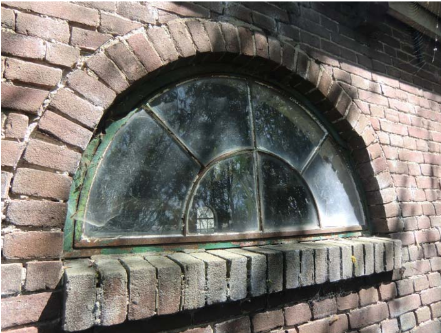
Eén van de halfronde stalvensters. Ook dit raam kan scharnieren en ventileren.
