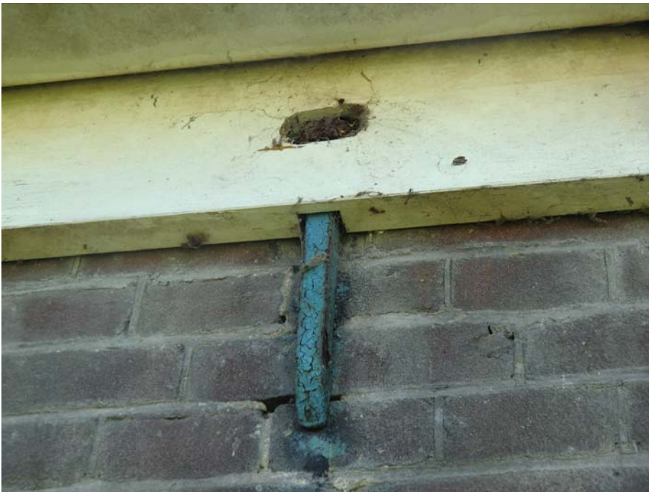
In de plank van de dakgoot is een opening uitgespaard voor de knoop van het muuranker.
