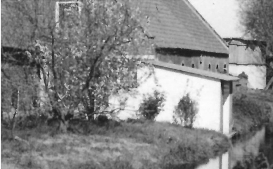
Detail van een foto uit 1971 met daarop de boenstoep. Het dak is hier nog bedekt met golfplaten.
