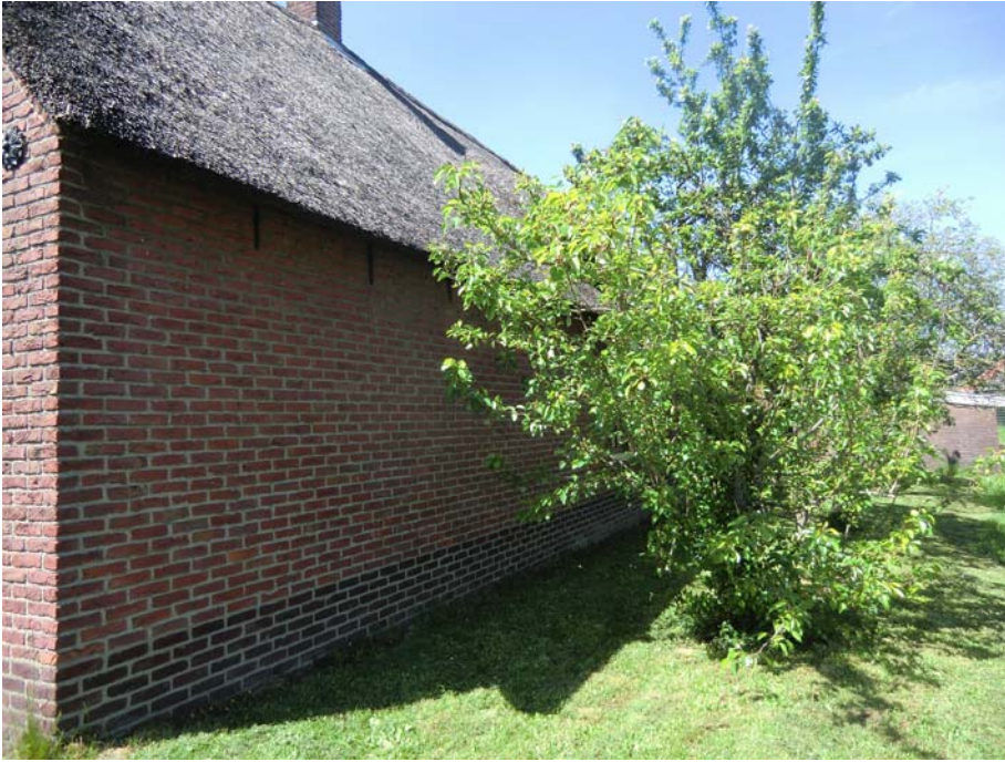
Voorzijde van de rechter zijgevel. Deze gevel is grotendeels blind.
