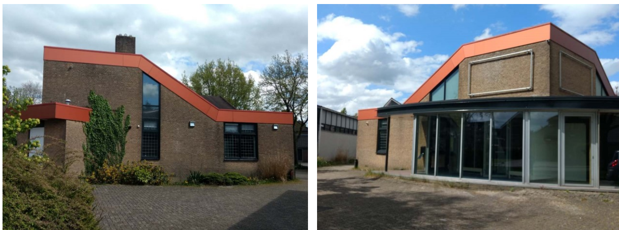
Figuur 14: Plat dak en beperkte vrije uitvalhoogte langs gevel
