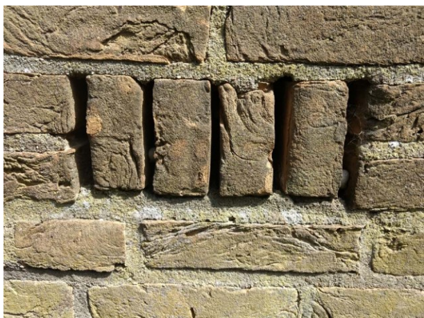
Figuur 16: Ventilatievoeg onder in de gevel (l) en strakke aansluiting kozijnen en trespa platen op gevel (r.)
