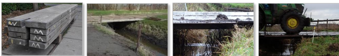
Foto's 29 t/m 32:: Tijdelijke brug . Door aanbrengen stalen rijplaten t.b.v. drukverdeling op walkant wordt oeverzone en sloot in tact gelaten.
