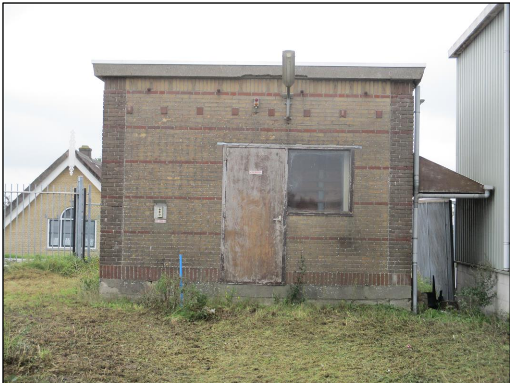
Figuur 4 Transformatorhuisje op de planlocatie welke gehandhaafd blijft in de toekomstige situatie.
