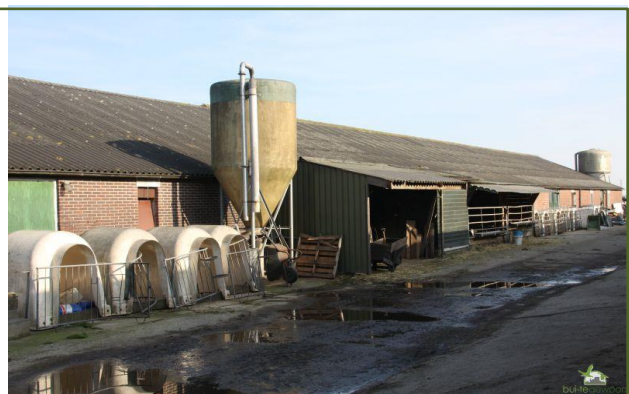
Figuur 9. Aanbrengen beplanting langs gevel bij kalver iglo's.
