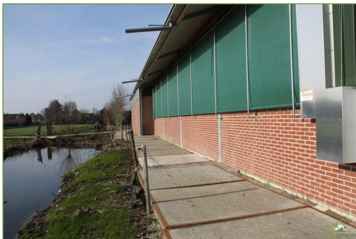
Figuur 4. zuidwestzijde nieuwe stal en erosie gevoelige oever.
