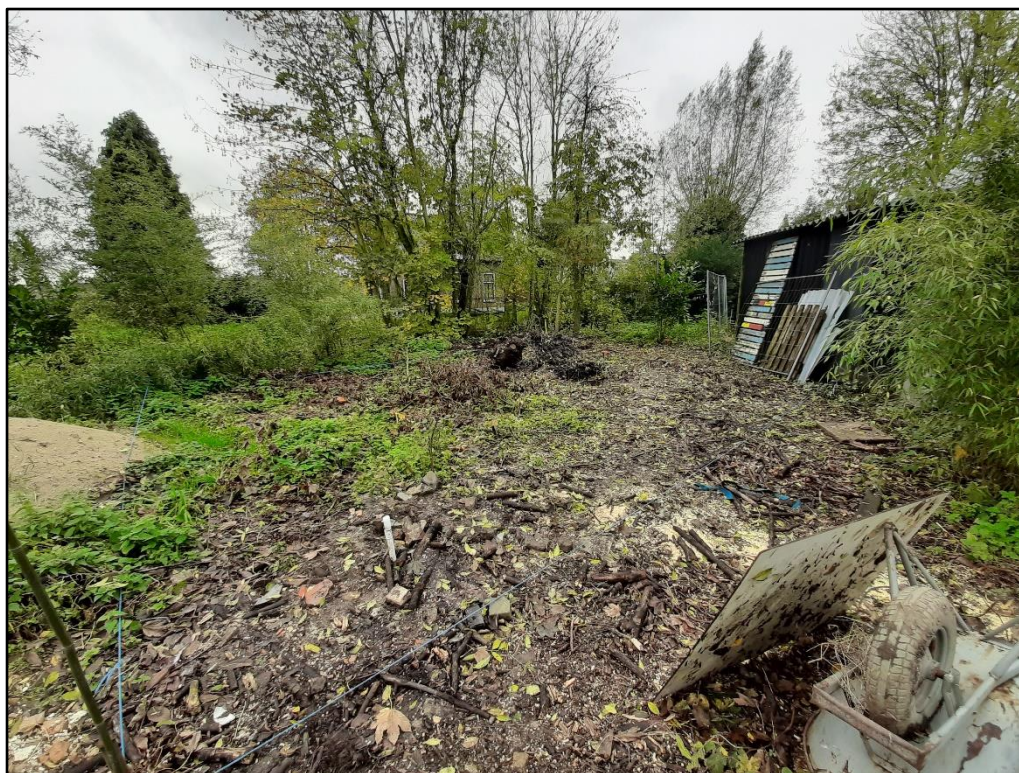
Figuur 4 Het bouwkaavel van de nieuwe woning. Er is een blauwe lijn gespannen (slecht zichtbaar) welke de exacte locatie weer geeft van de toekomstige woning.
