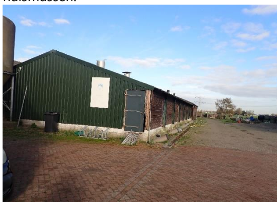
Foto 11: Perceel 30a, overzicht oostelijke kant van de kalverenstal 1 en 2.
