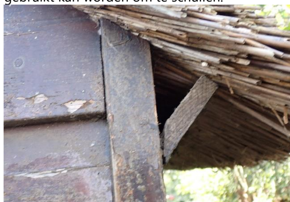
Foto 6: Perceel 30a, onder het rieten dak bevindt zich een opening die door huismussen en gierzwaluwen kan worden gebruikt om in te vliegen.
