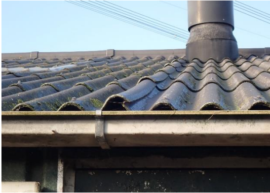
Foto 15: Perceel 30a, openingen onder de dakbedekking van kalverenstallen 3 en 4 is potentieel geschikt voor vleermuizen, huismussen en gierzwaluwen.
