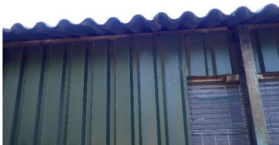
Foto 9: Perceel 30a, openingen onder de dakbedekking van de kalverenstal 1 en 2 zijn geschikt voor vleermuizen, gierzwaluwen en huismussen.
