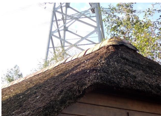
Foto 5: Perceel 30a, nok lijkt redelijk dicht te zijn, waardoor invliegen eigenlijk niet mogelijk is.
