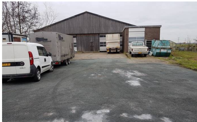
Foto 2: noordoostelijk gedeelte bedrijfsterrein / voormalige houtloods en droogkamer
