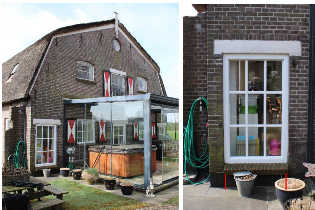
Figuur 9: Links: opname van de eindgevel. Rechts: vermaakte mestdeuropening. De lekorpel en de lage borstwering werden toegevoegd. De rode lijnen markeren de oorspronkelijke dagkanten.
