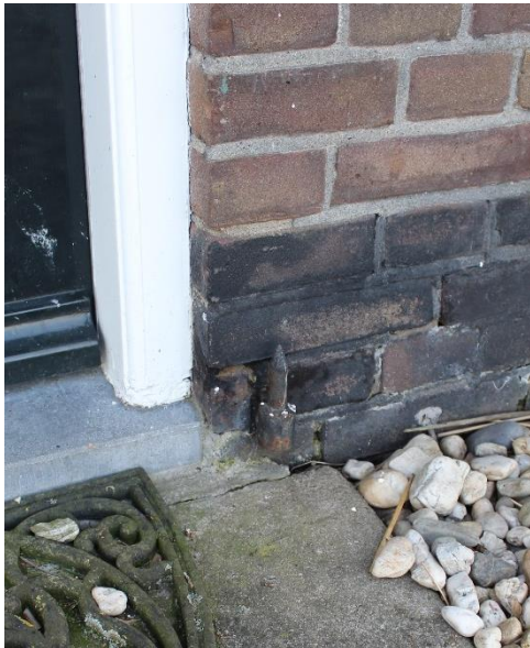
Figuur 12: Eén van de duimen waarin de oorspronkelijke staldeur opgehangen was.
