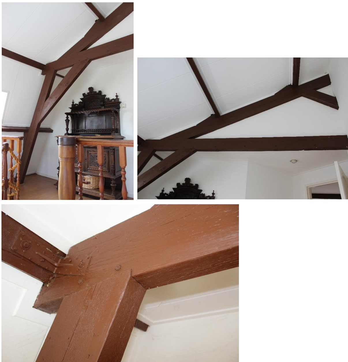
Figuur 18: Detailopnames van de kapconstructie.
