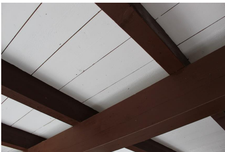
Figuur 17: Opname van de zoldervloerconstructie.
