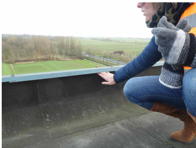
Figuur 14: Inspectie van de dakrand
