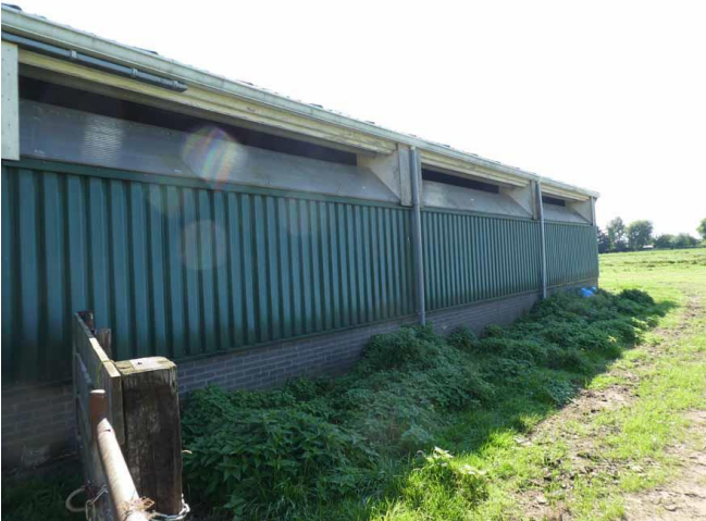
Figuur 18 Zijwand schuur met openingen
