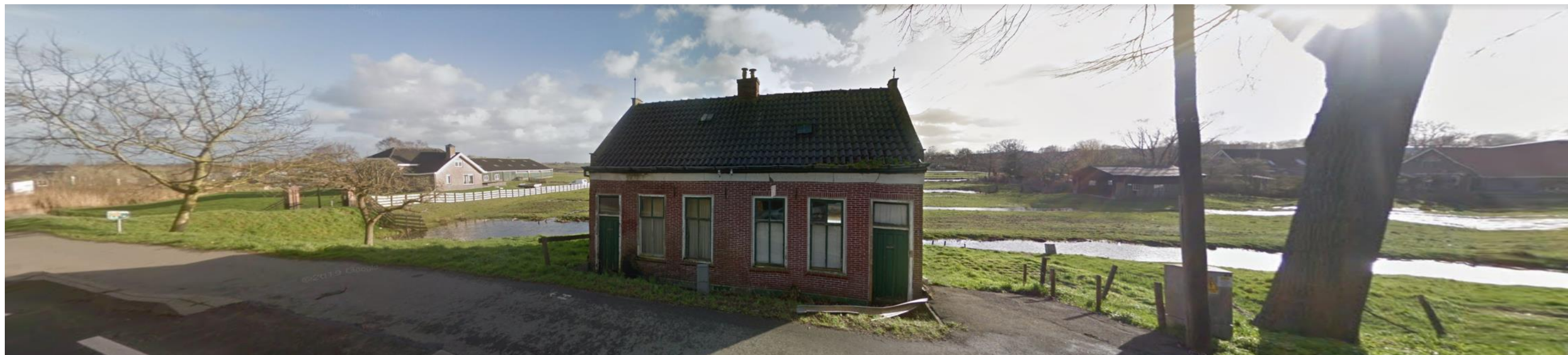
Bestaande situatie nr. 133 en 135 zonder rotonde. Bestaande woningen zijn bouwvallig en ontnemen doozicht. Eventuele sloop hiervan creëert meer zicht op het open polderlandschap. Daarnaast neemt een nieuwe rotonde ruimte in.
