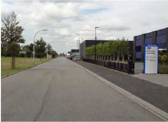
Verhoogd trottoir aan één zijde van grijze betonklinkers
