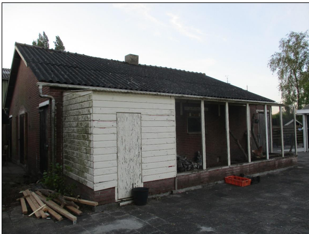
Figuur 1 De achterzijde van schuur C.
