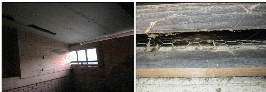
Figuur 4 Een gedeelte van het dak van schuur A beschikt over isolatieplaten, waardoor er een ruimte tussen de golfplaten en de isolatieplaten aanwezig is. De openingen zijn echter afgedicht met kippengaas ter preventie tegen ongedierte.
