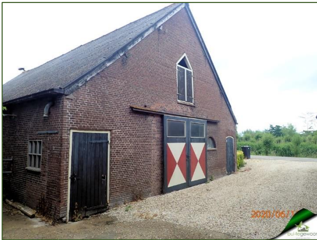
Figuur 7. Zuidzijde schuur (opstal 2) met toegankelijk (open) kozijn
