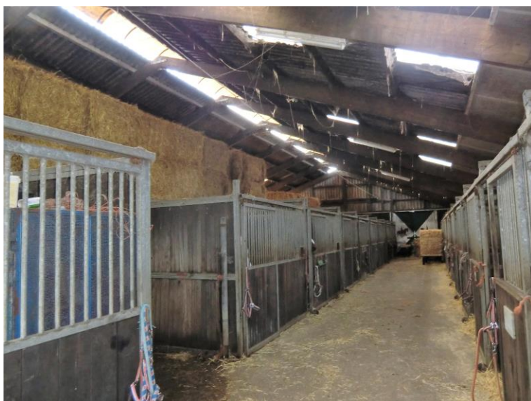
66 Het interieur van de paardenstal bestaat uit rijen van paardenboxen en opgestapeld hooi. De vloer is een gegoten, betonnen vloer. Net als in de koeienstal zijn tussen de asbestplaten van het dak plastic platen geplaatst voor de lichttoetreding in de stal.
