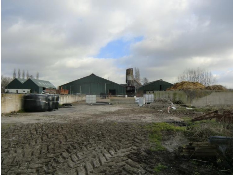
5 Het achterste deel van het erf kenmerkt zich door openheid en weinig bebouwing. Hier staan twee betonnen sleufsilo's, een romneyloods en een paardenbak (loods en paardenbak niet op foto). Op de foto zijn de achterzijde van de paarden- en koeienstal zichtbaar en helemaal links de binnenhal aan de weg.
