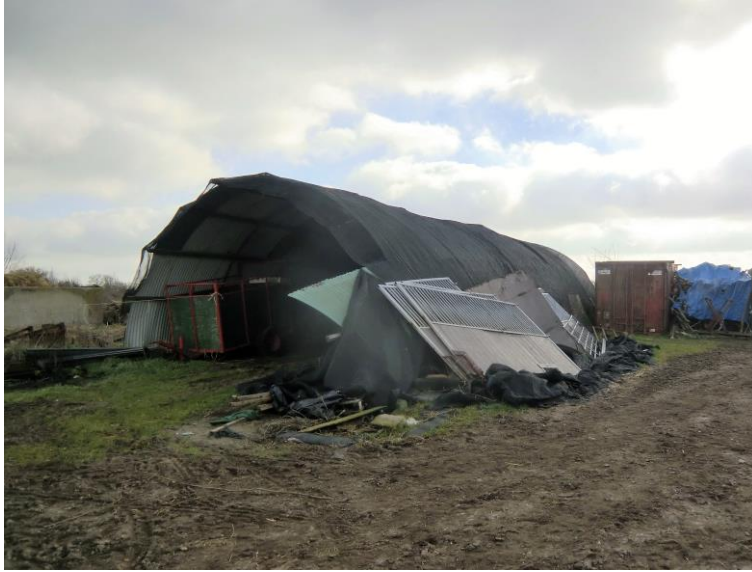
74 De voorzijde van de romneyloos aan de achterzijde van het erf. Over het dak van de loos ligt een doek.
