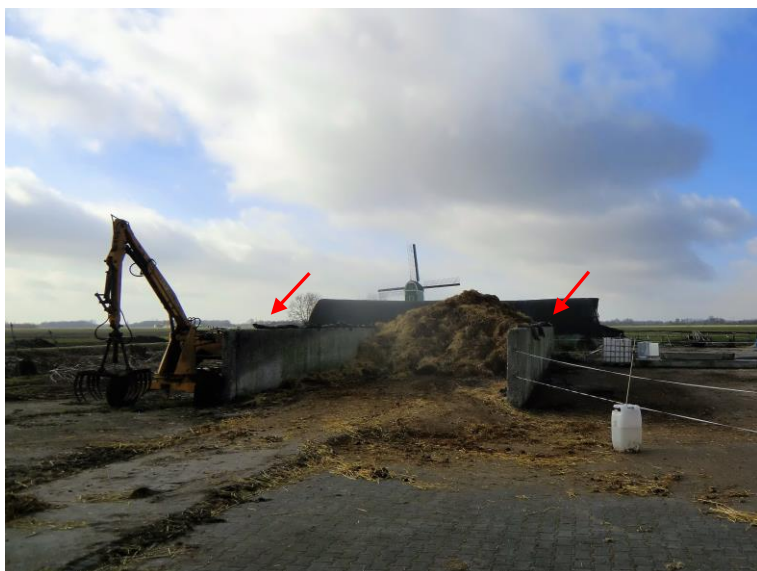
77 De zuidelijke sleufsilos. Met rode pijlen zijn de wanden van de silo aangegeven. De silo wordt gebruikt voor de opslag van paardenmest.
