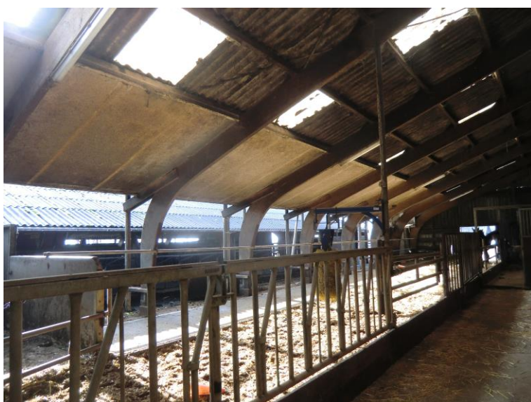
67 De stal gezien richting de open linker zijgevel. De constructie van de paardenstal bestaat uit tien achter elkaar geplaatste gelamineerde kniespanten.
