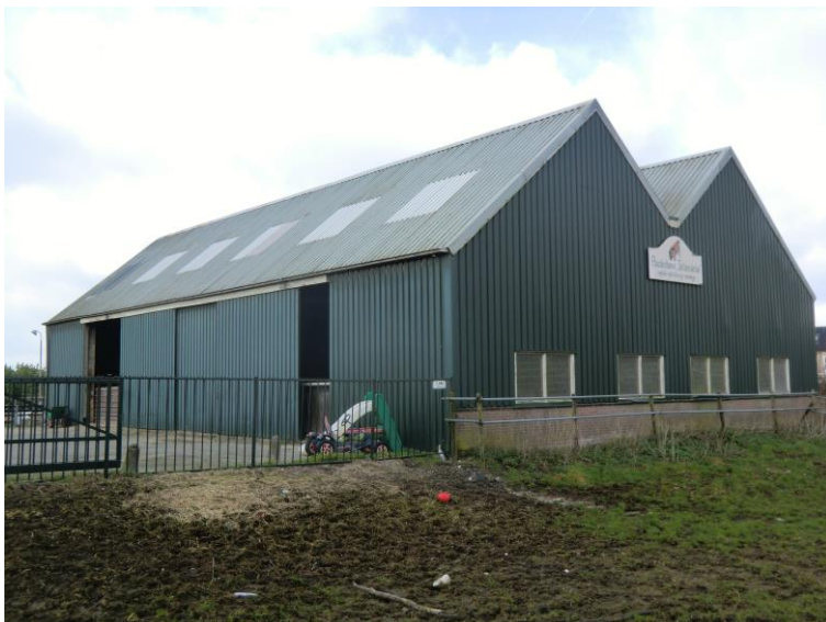
71 De voorgevel (links) en rechter zijgevel (rechts) van de binnenhal uit 2000. De gevels hebben een gemetselde plint met daarboven damwandplaten. De hal heeft een dubbel zadeldak met de nokken haaks op de weg.
