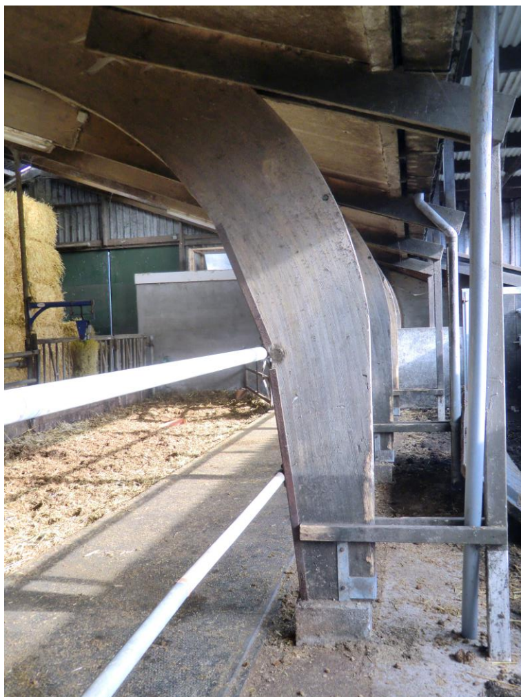
68 Detail van het verticale deel van de kniespanen en de 'knie'. De span-ten staan op gemetselde poeren. Het gelamineerde hout is op zijn breedst bij de knie, waar de constructie de meeste krachten op moet vangen.
