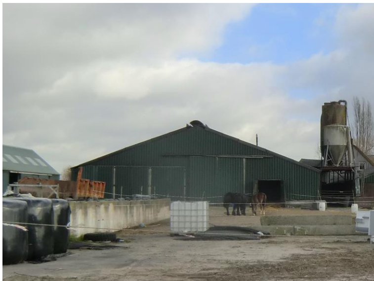
65 De achtergevel van de paardenstal, bestaande uit damwandplaten met meerdere hoge deuren van hetzelfde materiaal.
