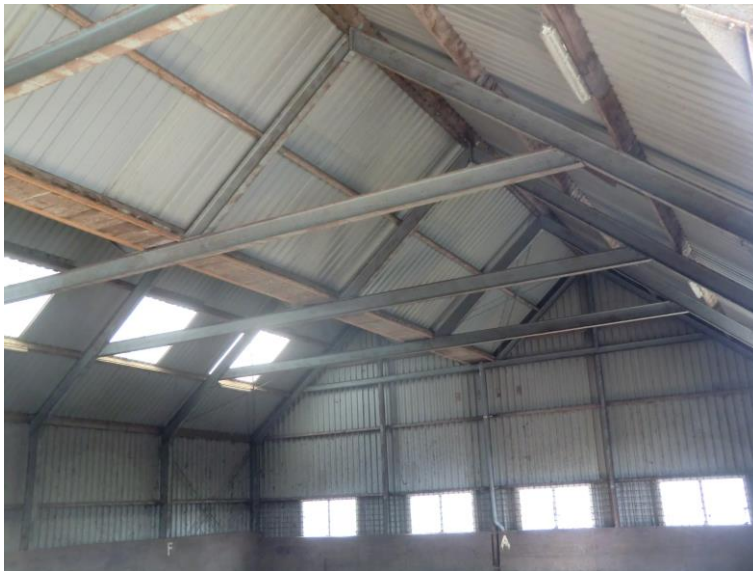
73 Detail van de kapconstructie van de hal. Op de stalen I-profielen zijn gordingen aangebracht met daarop dakplaten.
