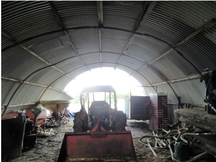
75 Het interieur van de loos. De constructie bestaat uit gebogen spanten met daarop gordingen en golfplaten. De loos wordt gebruikt voor opslag.
