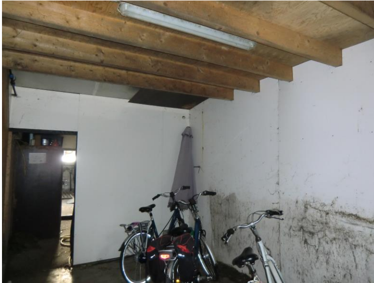
70 Het portaal van binnenuit gezien. Het portaal is zeer eenvoudig met een enkelvoudige, grenen balklaag en platen tegen de gemetselde muren.
