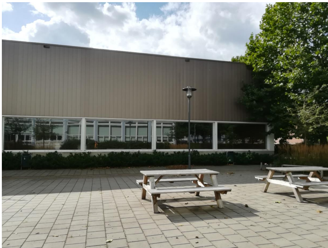
Foto 5. Westzijde Schoonhovens College: zicht op het westelijke deel van de uitbouw aan de zuidkant; opgebouwd uit bruine gladde platen. Op geen enkele plek is dit bouwdeel geschikt voor vleermuizen.
