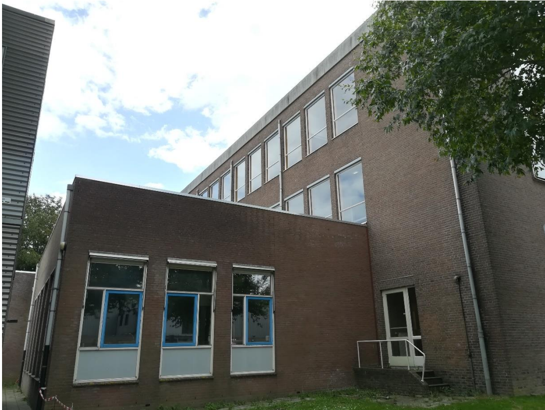
Foto 1. Westzijde: Zicht op de westzijde van het centrale deel van het Schoonhovens college: beide gemetselde muren hebben open stootvoegen boven de ramen. Geheel links is de golfplaten bijgebouw te zien, dat tussen beide 'units' een diepe toegankelijke dilatatievoeg heeft.
