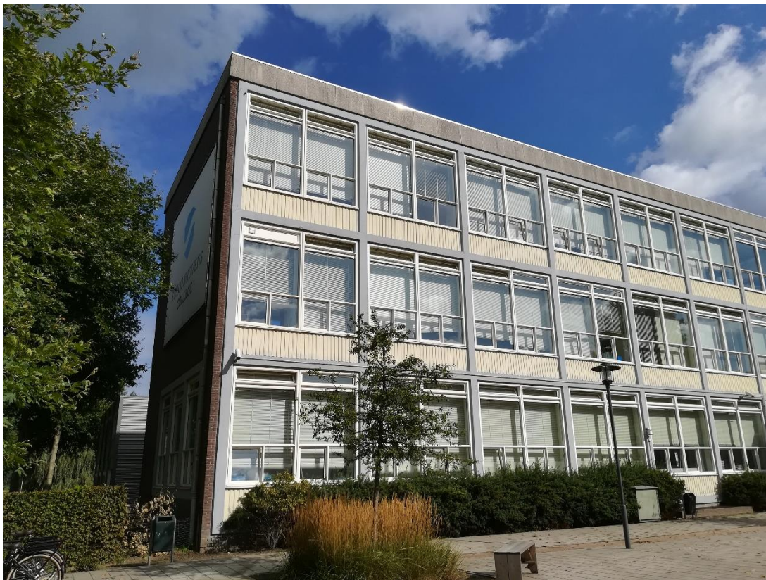
Foto 1. Het centrale deel van het Schoonhovens College, opgebouwd uit metselwerk met een plat dak, betonnen omranding rond de ramen en golfplaten borstwering.
