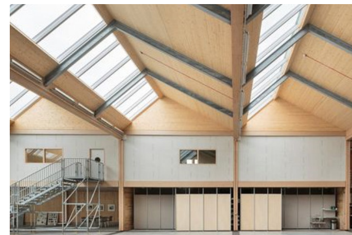
sheddaken zorgen voor licht in de sporthal Vitsoe fabriek Vitsoe and Martin Francis
