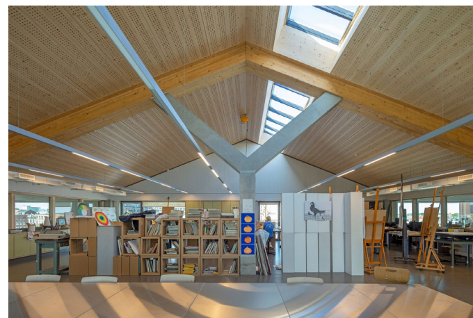
sheddaken zorgen voor aangenaam licht Campus Cadix, Antwerpen Korteknie Stuhlmacher architecten
