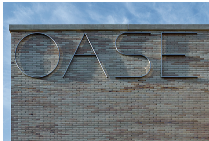
naamgeving gebouw op de gevel Kindercluster de Oase, Utrecht Geurst & Schulze architecten
