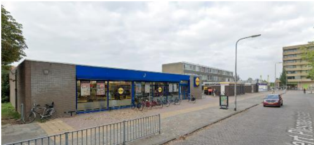
Figuur 2.1 Huidige situatie plangebied gezien vanaf de Albert Plesmanstraat (Bron: Google Maps)
