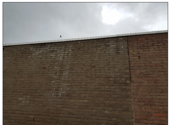
Figuur 9. Close-up van de muur van de Lidl
