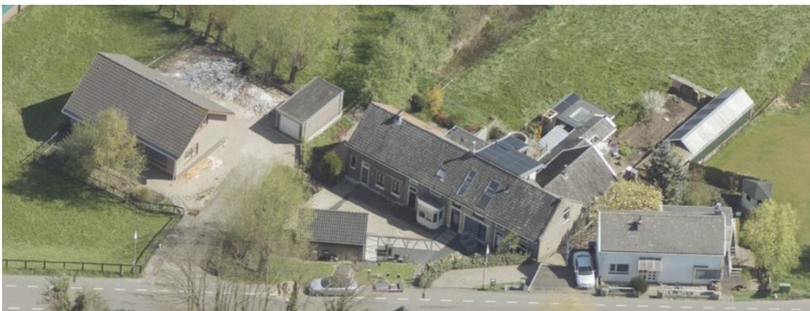
Figuur 2.5: Impressie bebouwing overzijde, aan de zuidzijde van het plangebied
