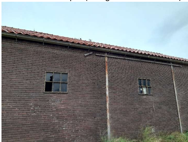
Figuur 11. Loods met dakpannen
