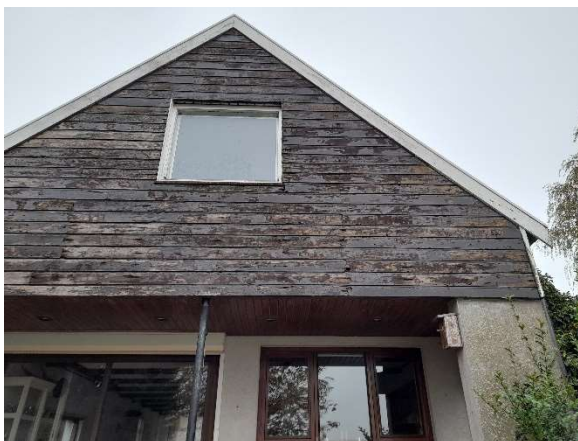
Figuur 9. Dakomlijsting en houten gevelbekleding
