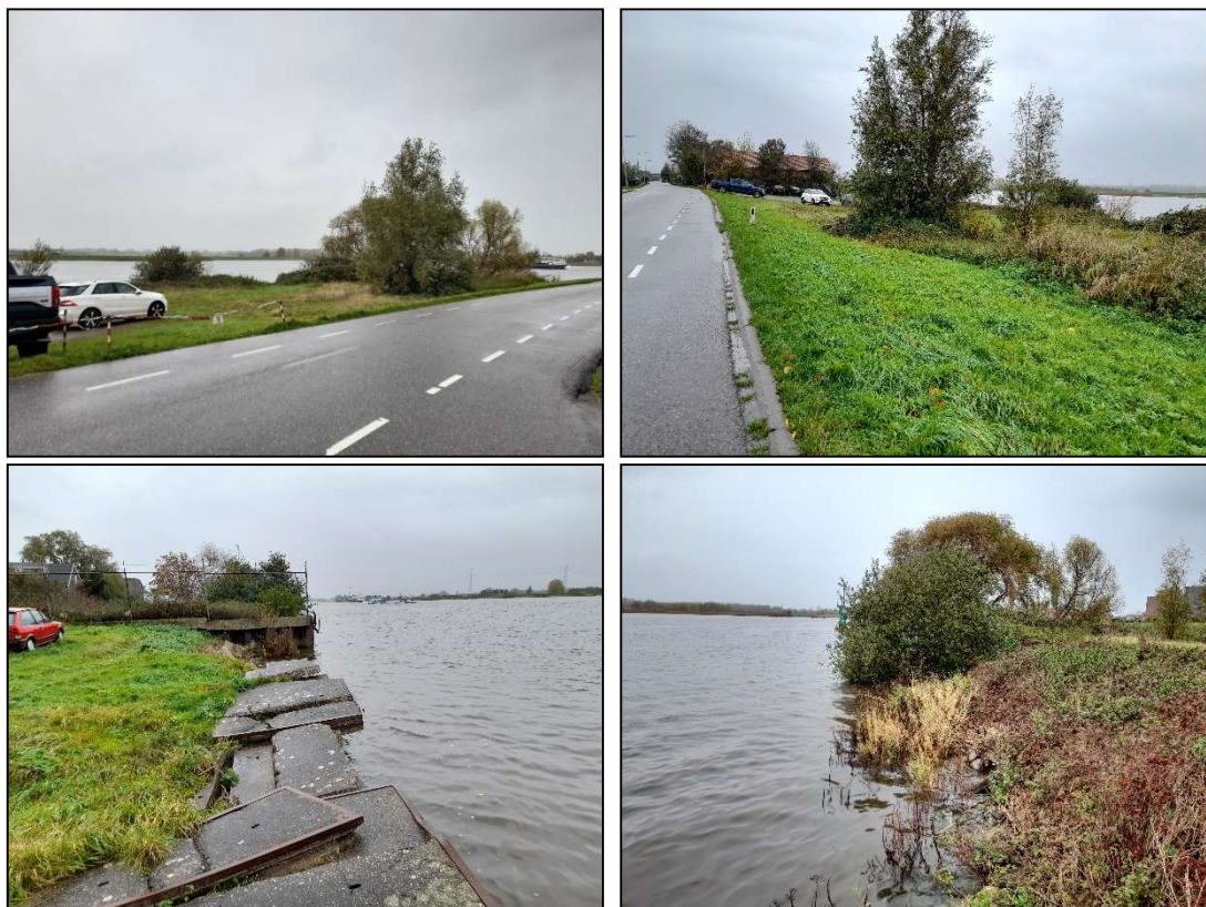
Figuur 5. Impressie van het braakliggend terrein op de twee noordelijk gelegen kavels
