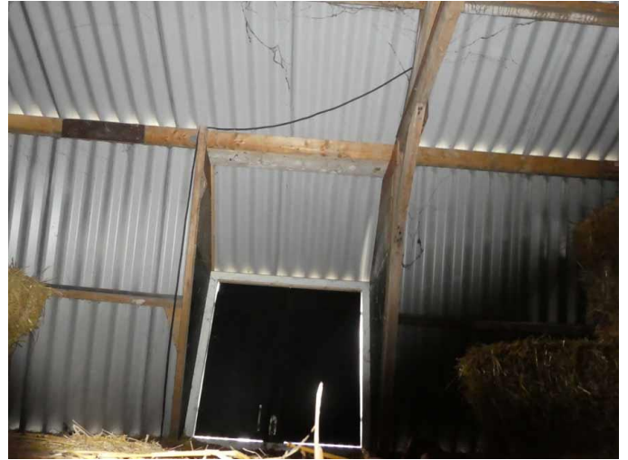
Figuur 12 Binnenzijde dakconstructie
