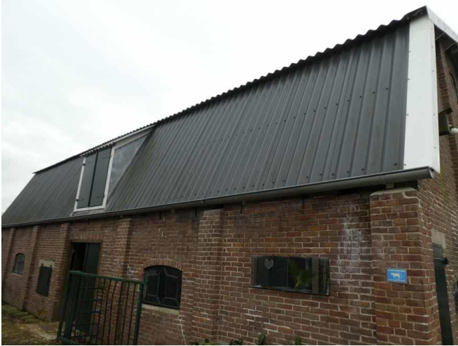
Figuur 13 Dak jongveestal metalen golfplaten
