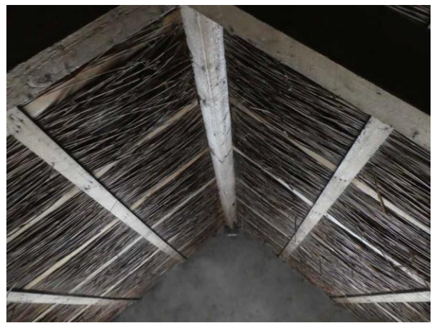
Figuur 15 Binnenzijde dakconstructie bijgebouw
