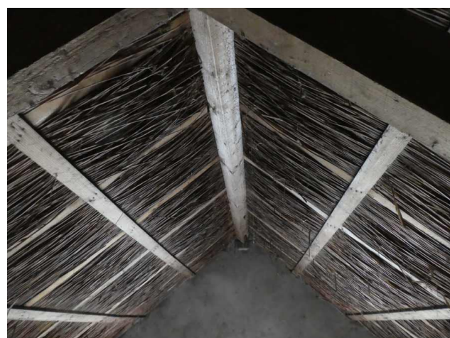
Figuur 20 Dakconstructie binnenzijde bijgebouw
