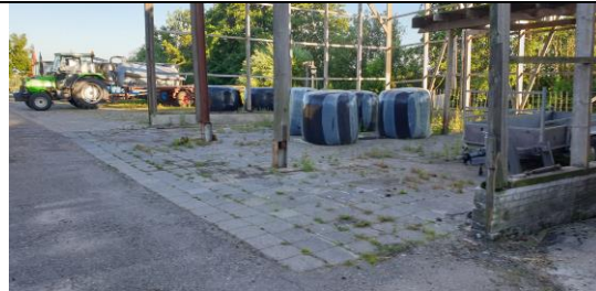
(te slopen) kapschuur (vml. hooischuur)
