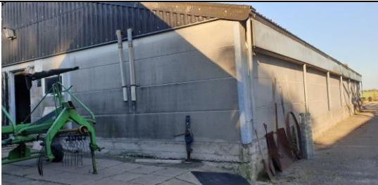
Ligboxenstal (voorzijde), asbestdak+goten
