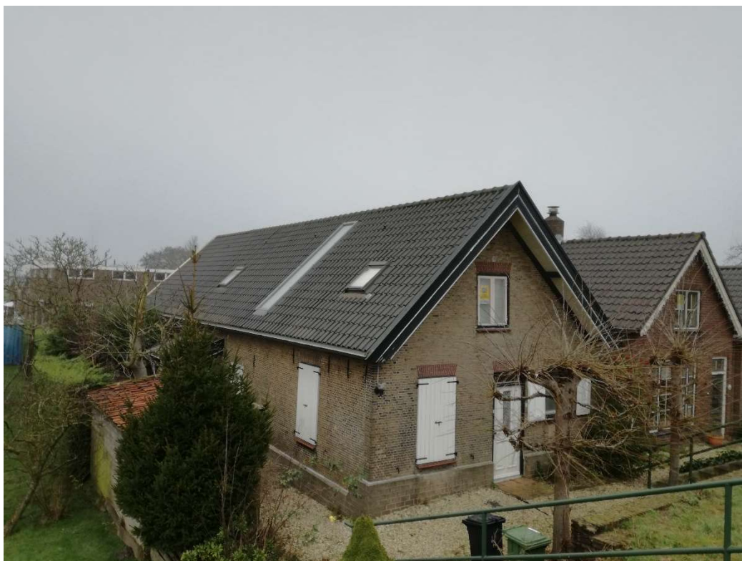
Foto 9. Schuwacht 148 (links) en 146 (rechts). Het dak van Schuwacht 146 is vernieuwd met nieuwe pannen en dakisolatie (zie foto 10). De dakramen sluiten goed aan.
