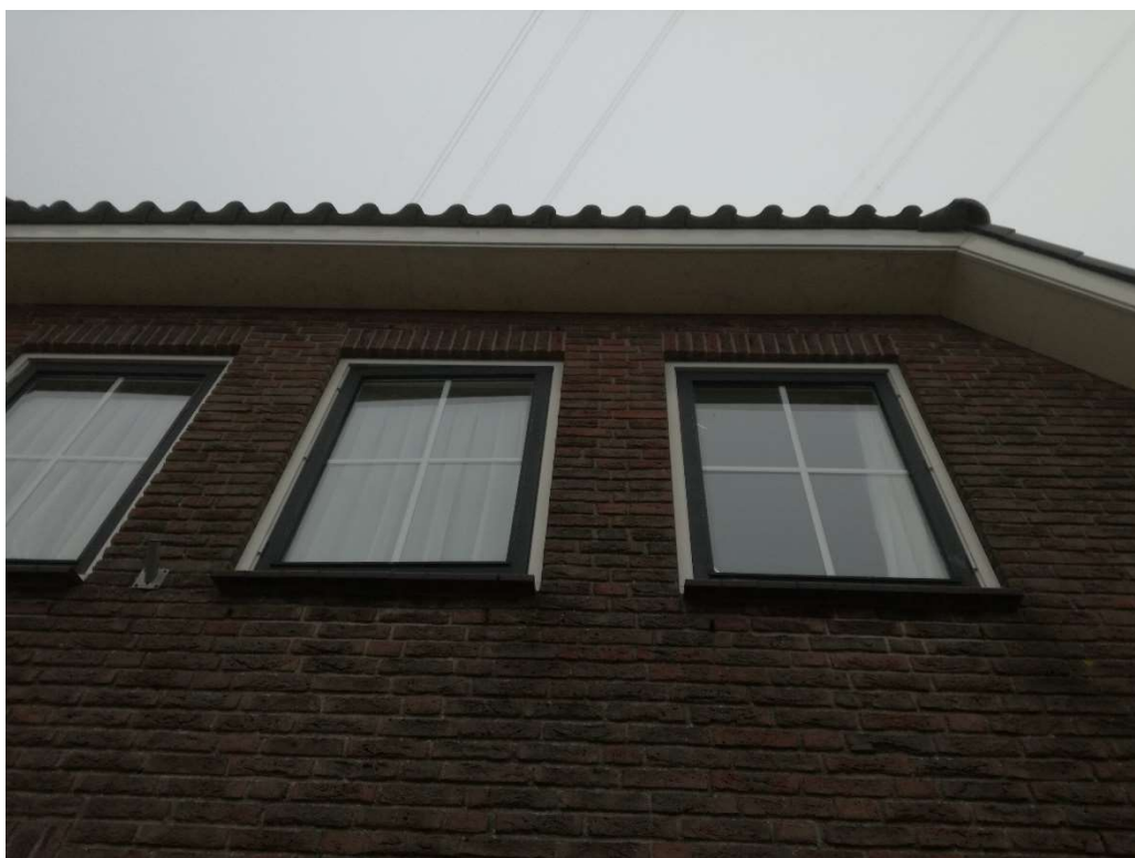
Foto 18. Het woongedeelte van Schuwacht 152 is nieuw gebouwd met spouwmuren (op de foto zijn de open stootvoegen niet goed te zien, maar ze bevinden zich boven en onder de ramen). De dakgoot liggen in een ombouw, die overgaat in de holle overstek langs de aflopende gevels van de wolfskap. Tussen de kantpannen op de aflopende delen en de overstek is voldoende ruimte voor vogels en vleermuizen om de ruimte onder de pannen te bereiken.
