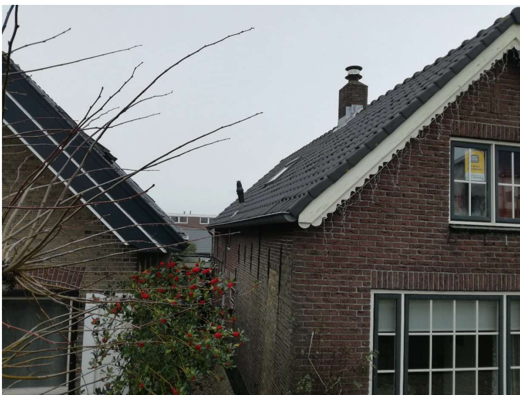
Foto 6. De voorzijdes van Schuwacht 146 (links) en 148 (rechts). Tussen de kantpannen van 146 en de daklijst is voldoende ruimte voor mussen, gierzwaluwen en vleermuizen om onder het dak te komen. Langs het voorraam is ook een kleine kier, die voldoende ruimte biedt voor vleermuizen om te verblijven. Bij beide panden is er voldoende ruimte onder de dakgoot om onder het dakbeschot te komen (zie ook foto's 7 en 10).
