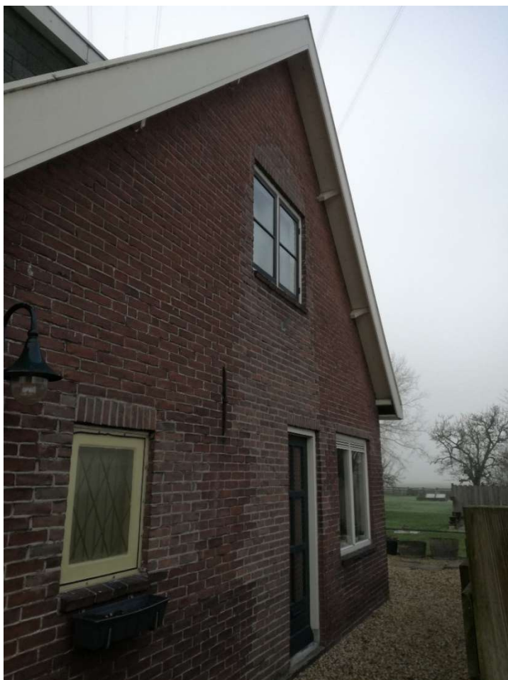
Foto 25. De kopgevels van Schuwacht 154a zijn voorzien van brede houten overstekken met waterborden. Tussen de muur en de overstek zijn kieren aanwezig, waardoor vleermuizen onder het dak kunnen komen.
