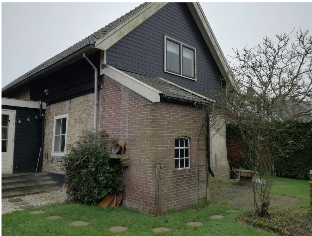
Foto 11. Achterzijde van Schuwacht 148 met houten betimmering en de kleine uitbouw. De ruimte achter de betimmering tegen de achtergevel is bereikbaar voor vleermuizen via een kier onderlangs. De kleine uitbouw is leeg; de kieren tussen kozijnen langs de deur (hier niet te zien) en de muur zijn dusdanig groot dat vleermuizen in de uitbouw kunnen komen. De taxushaag recht s op de achtergrond scheidt Schuwacht 148 van 150.
