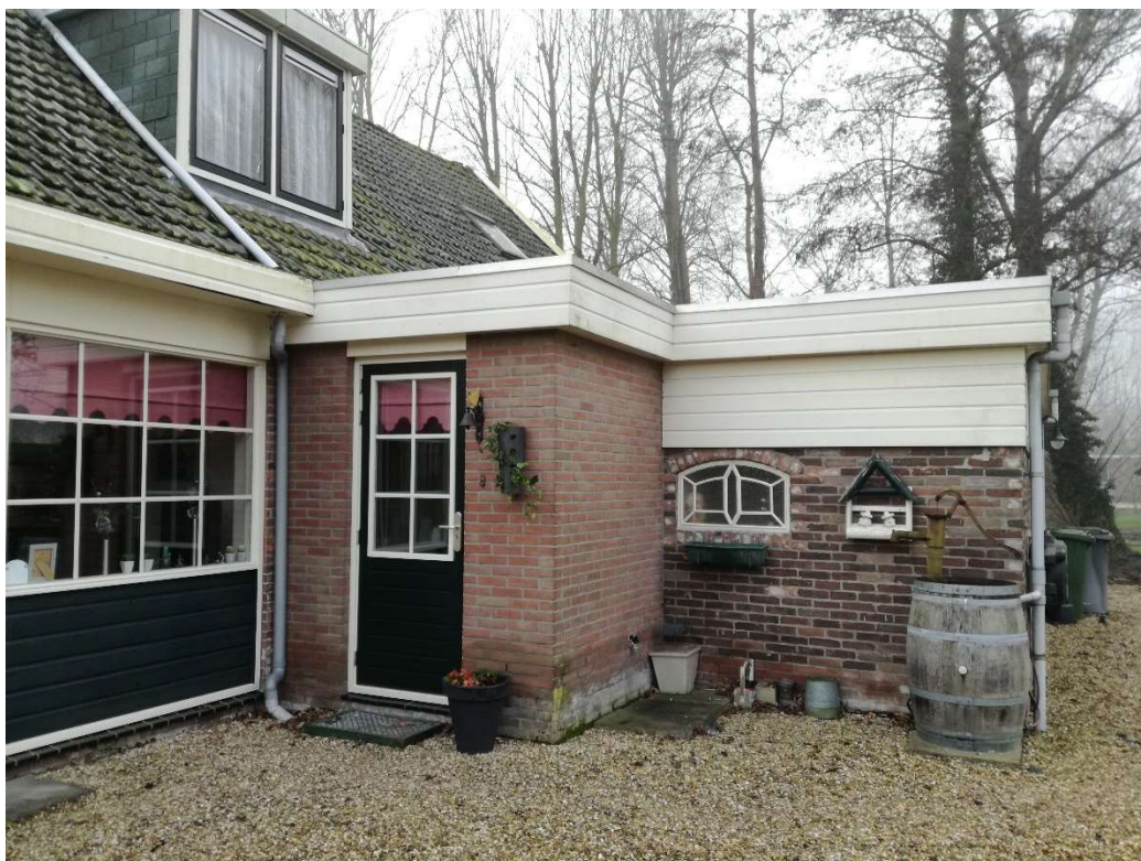
Foto 24. Aan de achterzijde van Schuwacht 154a is de oorspronkelijke schuur verbouwd tot keuken en het oorspronkelijke schuin aflopende dak is vervangen door een plat dak. Het hoogteverschil is opgevangen door een brede daklijst; de muur aan de noordzijde (rechts op de foto) loopt enkele cm's door onder de daklijst. De holle ruimte achter de daklijst is bereikbaar via diverse kieren.
