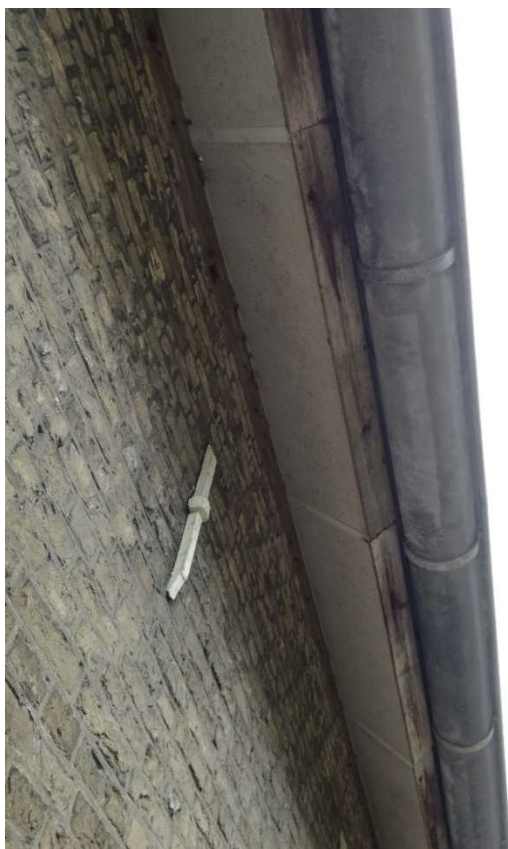
Foto 10. Vanaf de onderzijde is goed te zien dat het dak van Schuwacht 148 voorzien is van een isolatiepakket. Tussen de isolatie en de dakgoot is voldoende ruimte voor vogels en vleermuizen om onder de pannen te komen.
