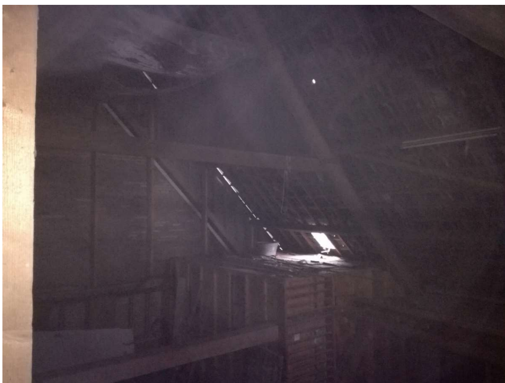
Foto 22. Zicht op de (lage) zoldering aan de voorzijde van de schuur. Doordat de schuur groot is, niet veel gebruikt wordt en vele rustige hoekjes heeft, is de schuur geschikt als (incidentele) rustplek voor bunzing en steenmarter. De schuur en de zolders zijn niet geheel geïnspecteerd op sporen van marters (prooiresten, latrines) vanwege veiligheid. De open balkenstructuur van de schuur is ook geschikt als verblijfplaats voor vleermuizen als gewone grootoorvleermuis en laatvlieger.
