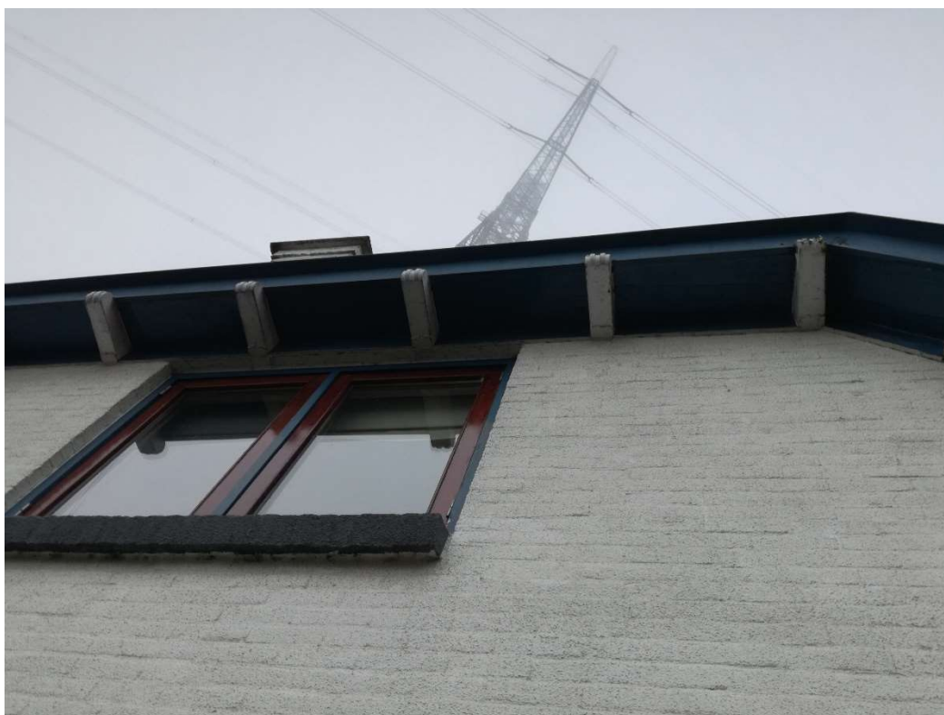
Foto 4. Er zijn geen kieren tussen de dakoverstek en de muren, en de dakgoot en de muren aanwezig. Ook heeft het pand geen spouwmuur. Het pand is daarmee niet geschikt voor vleermuizen.
