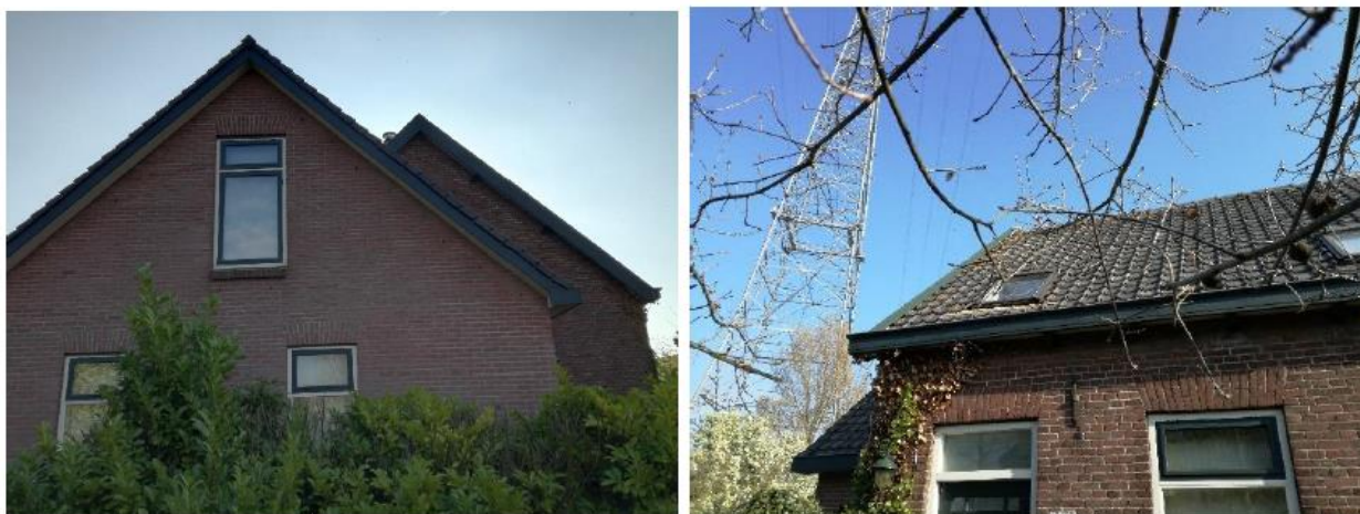
Figuur 2. Links: de westelijke kopgevel van de aanbouw van nr. 46, waar de vleermuisverblijfplaats zich bevindt. Het terugspringende dak rechts is het oude pannendak, dat ook op de rechterfoto te zien is. Rechts; het oude dak van nr. 46 waar tegen het waterbord aan het nest van de huismus zich bevindt.
