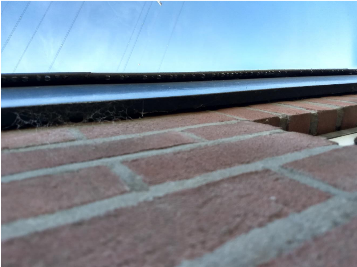
figuur 10: gleuf achterkant Schuwacht 46
