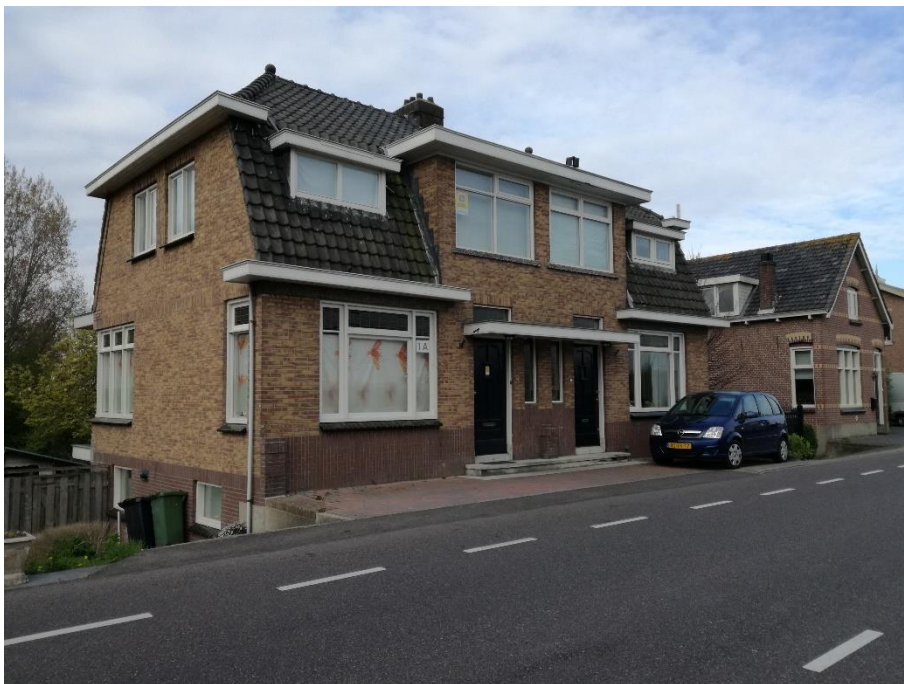
Figuur 3. Noord 1a (links) en Noord 1b (rechts). Achter de woningen liggen kleine tuinen tot aan de Sliksloot.
