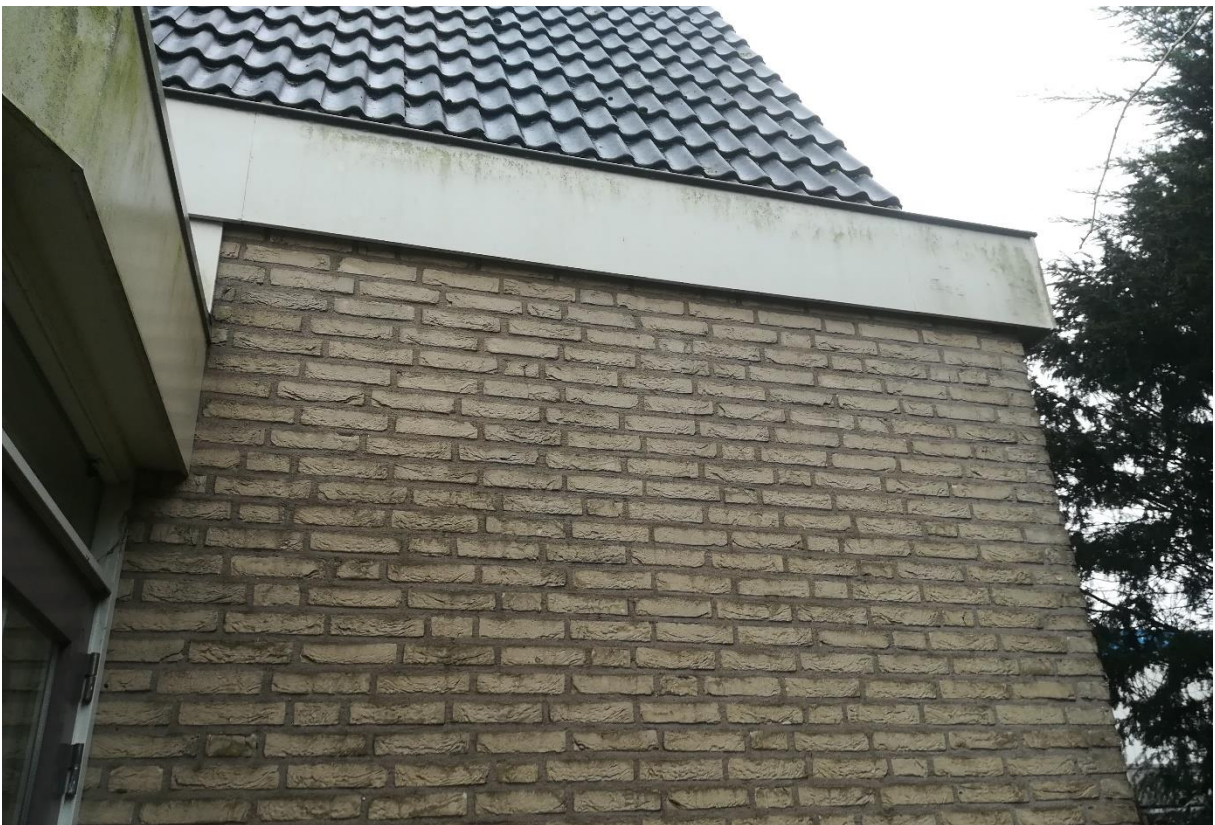
Foto 4. Rondom het pand zijn daklijsten aanwezig, waarin de dakgoot zit verwerkt. Ook tussen de daklijst en de muur zijn geen kieren aanwezig. Ze sluiten goed aan en zijn afgesloten met latten.
