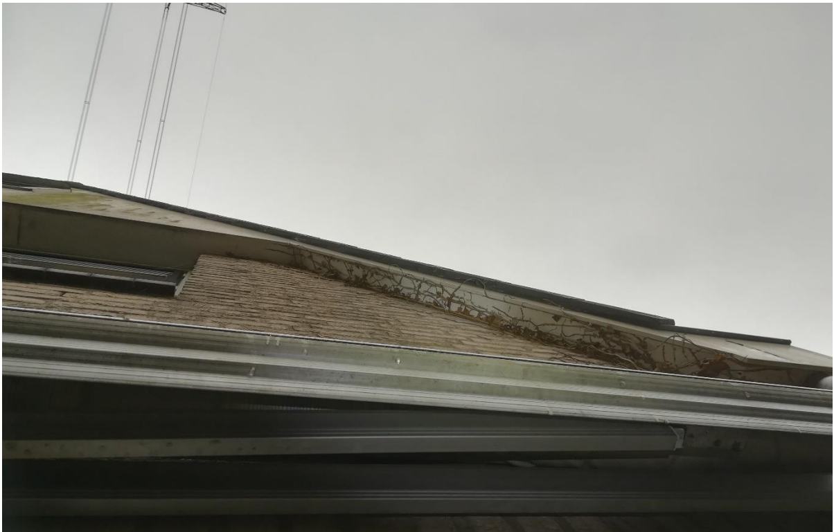
Foto 3. Tussen de kantpannen en de overstek is geen ruimte aanwezig. Ook langs de dakoverstek en de gevel zijn geen kieren gevonden. De betimmering in de punt is ook goed afgesloten. Vleermuizen kunnen op geen andere manier dan via de open stootvoegen in de spouw komen.
