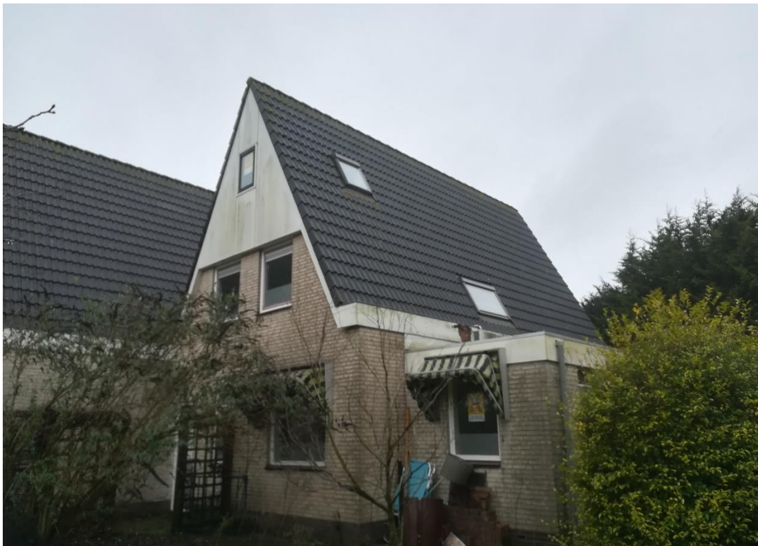
Foto 1. De te slopen woning, gezien vanaf de zuidoostelijke hoek van de tuin. Het dak is steil en onbereikbaar vanuit de dakgoot. Tussen de kantpannen en de dakoverstek zitten geen kieren. Het dak is daarom niet geschikt als broedplek voor huismussen, gierzwaluwen en spreeuwen.
