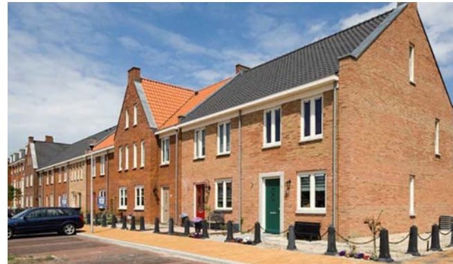
Variatie in kleurstelling van de gevels aan de kade
