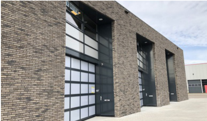
Verbijzondering van de gevel
