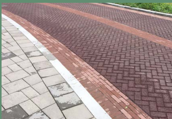
Voorbeeld asfalt met print
