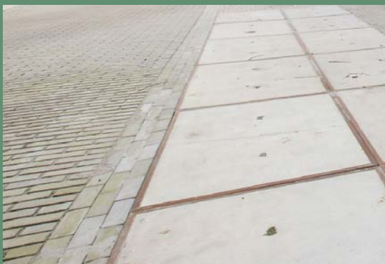
Voorbeeld strook van stelconplaten
