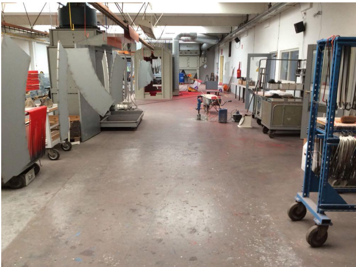
Foto 3: Betonboring t.b.v. peilbuis 1005. Peilbuis kon niet worden geplaatst vanwege werkzaamheden
