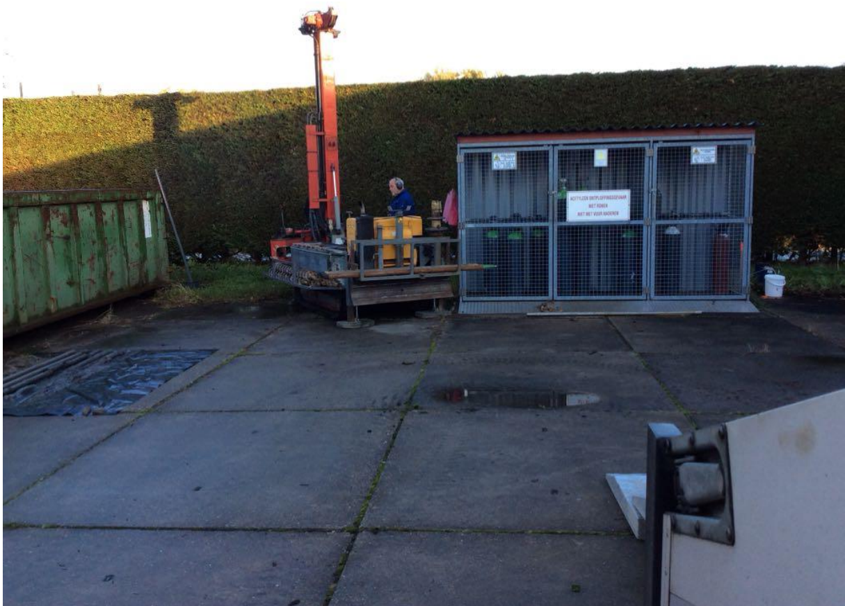
Foto 1: Machinale plaatsing peilbuis 1000, filterstelling 31 - 32 m-mv
