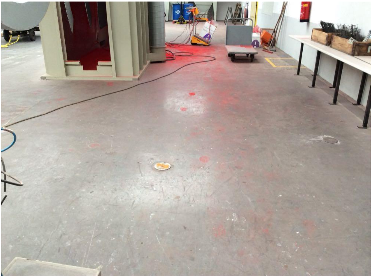
Foto 5: Locatie bestaande peilbuis 108 in de spuiterij
