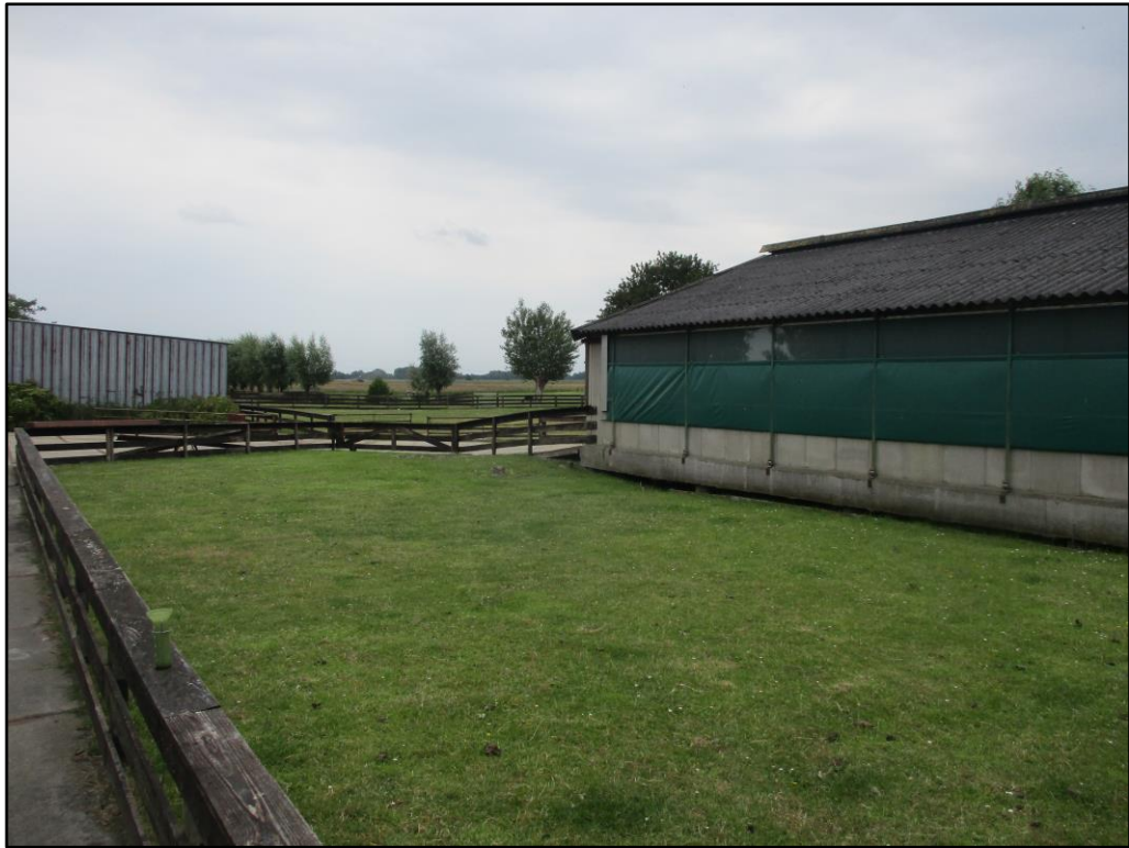
Figuur 3 Een gedeelte van de schapenschuur (D) en wagenloods (I) op de planlocatie.
