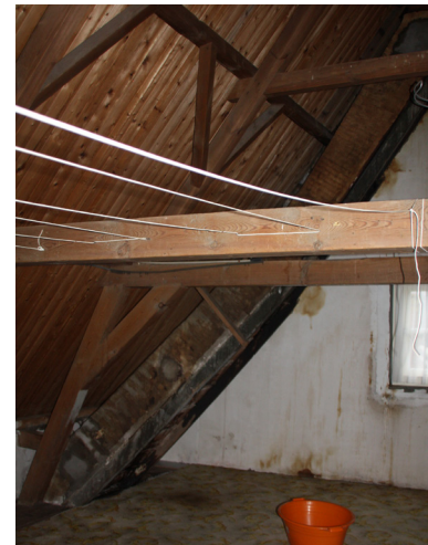
rookkanaal boven de schouw in de keuken, met sleepconstructie
