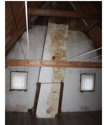
rookkanaal boven de schouw in de woonkamer
