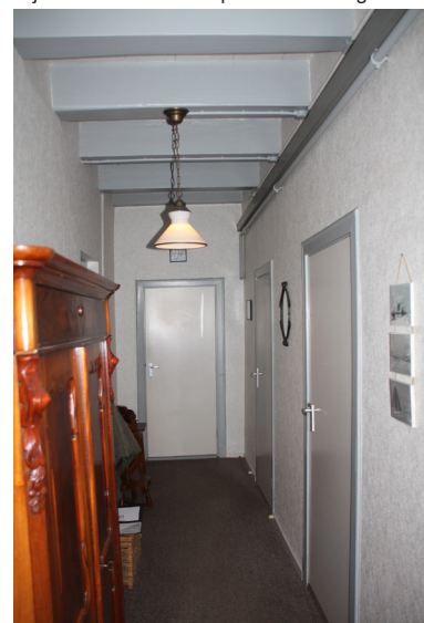
De balklaag van de verdiepingvloer en zoldervloer is in twee richtingen overspannen (haaks en parallel aan de voorgevel)
