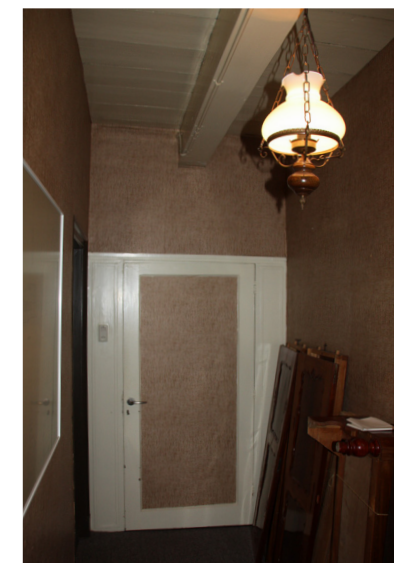
De balklaag van de verdiepingvloer en zoldervloer is in twee richtingen overspannen (haaks en parallel aan de voorgevel)
