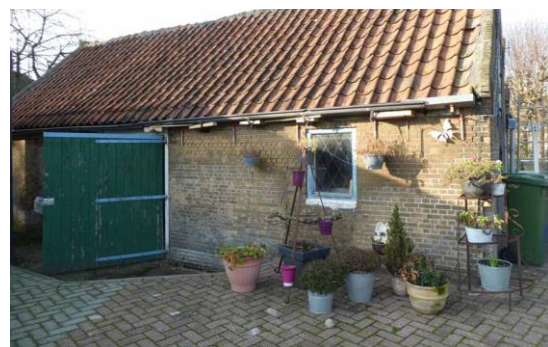
Figuur 14 Zijgevel schuur
