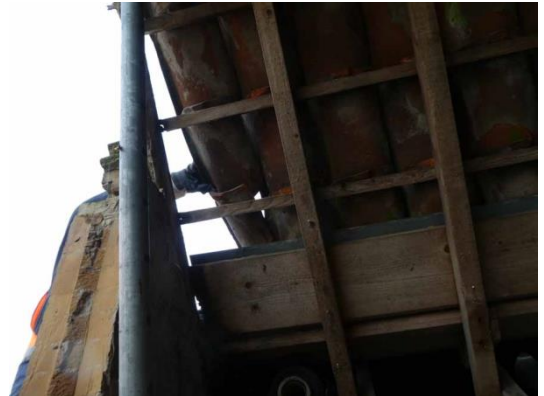
Figuur 16 Dakconstructie gezien vanaf binnenzijde
