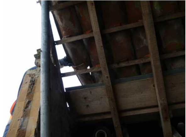
Figuur 9 Dakpannen vanaf binnenzijde schuur
