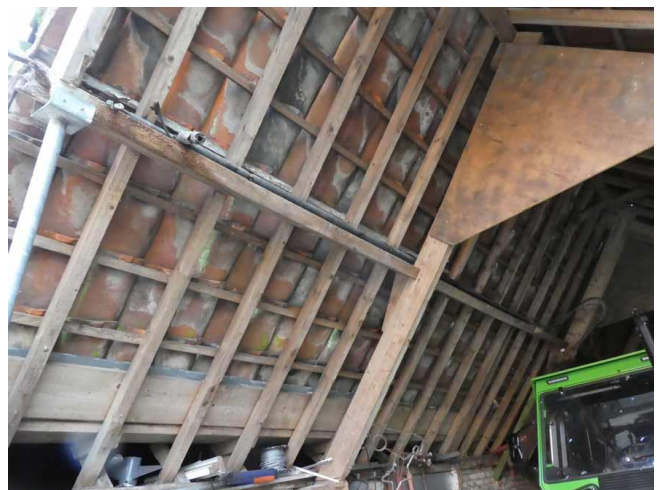
Figuur 17 Dakconstructie binnenzijde schuur
