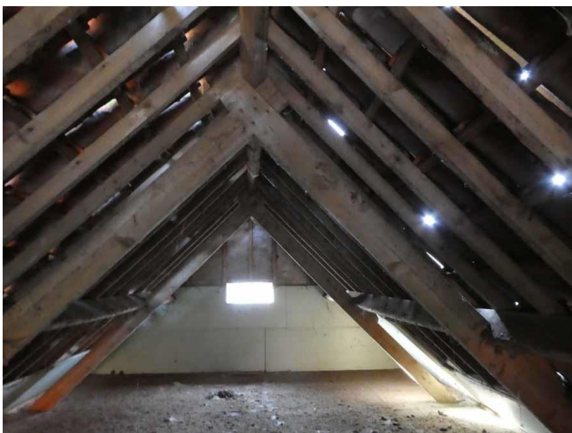
Figuur 12 Zolder schuur en dakconstructie
