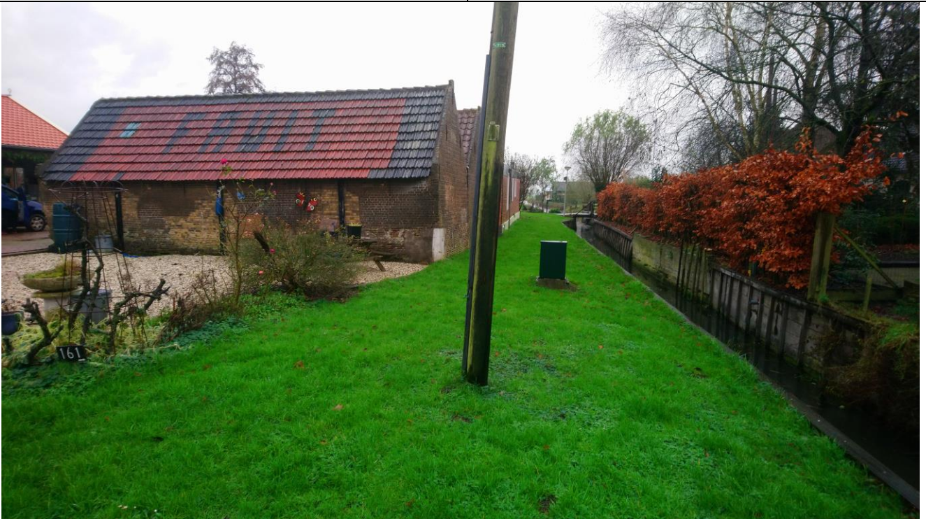
De oude schuur waar een nieuwbouw woning wordt gerealiseerd.
