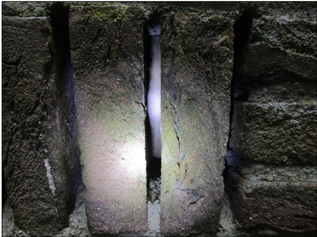
Figuur 3 De spouwmuur is geïsoleerd met pir glaswol isolatieplaten.
