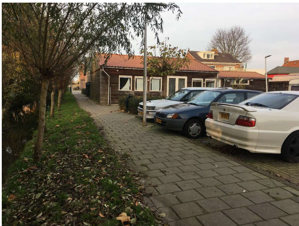
Figuur 2 Het pand is opgetrokken uit houten betimmering en draagt een dak van dakpanplaten.
