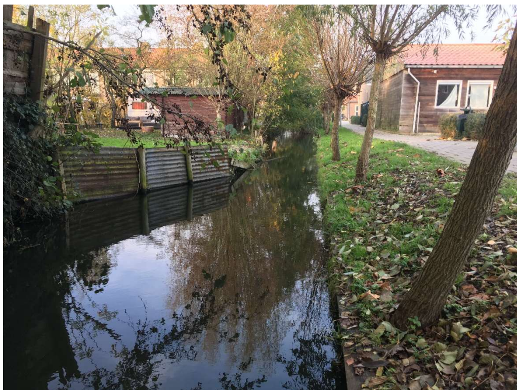
Figuur 4 De initiatiefnemer is voornemens de bestaande bebouwing te saneren ten behoeve van de realisatie van drie appartementen.
