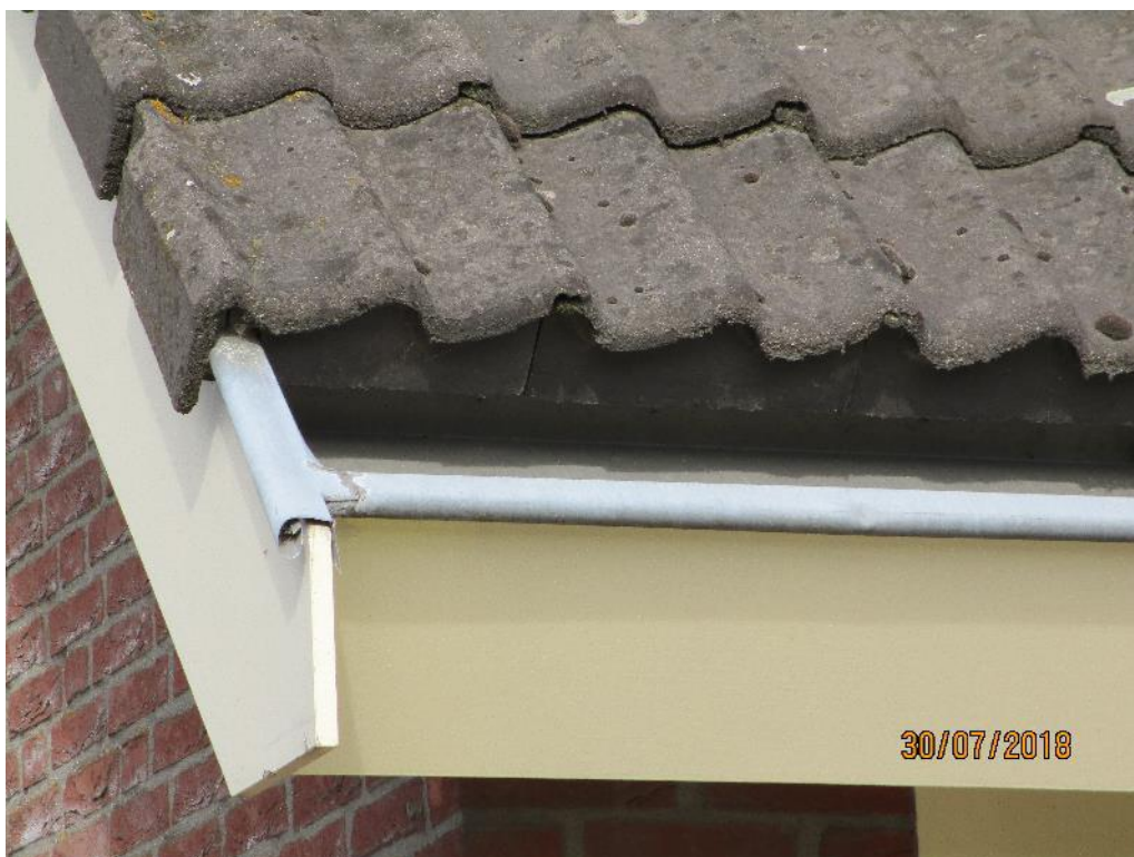
Figuur 3 De onderste rij dakpannen zijn, door de verlenging aan de onderkant, ongeschikt voor huismus om een nest onder te maken.
