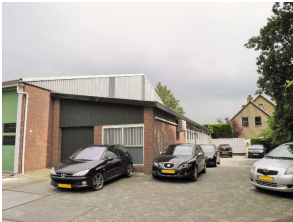
Figuur 6. Het kantoor aan de westzijde van de loods.
