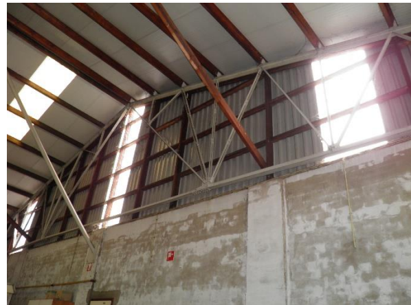
Figuur 11. Overzicht van de binnenzijde van de loods.
