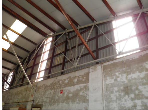
Figuur 9. Overzicht van de binnenzijde van de loods.
