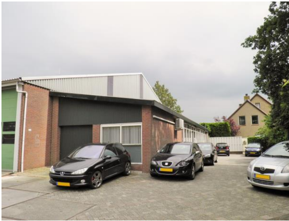
Figuur 4. Het kantoor aan de westzijde van de loods.
