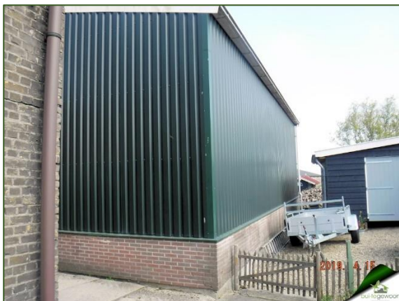
Figuur 13. Opstal 9 (plaatstalen nieuwe loods)
