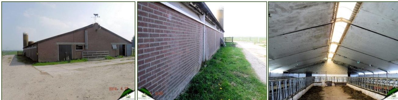
Figuur 6. Opstal 2 (voormalige melkstal)
