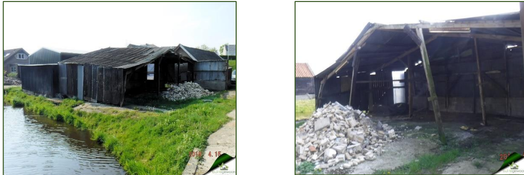
Figuur 10. Opstal 6 (oude staalplaten loods)
