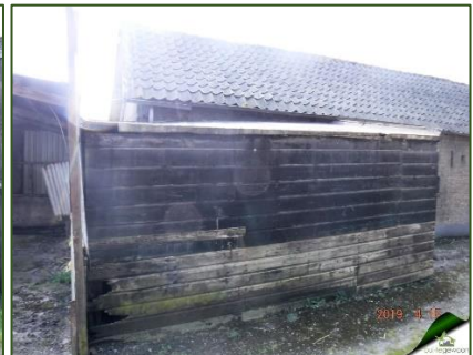
Figuur 12. Opstal 8 (aanbouw schuurtje)
