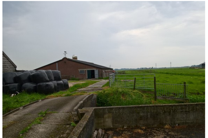
Foto 2: zuidoostelijk gedeelte locatie / ligboxenstal (vanaf noordwestzijde)
