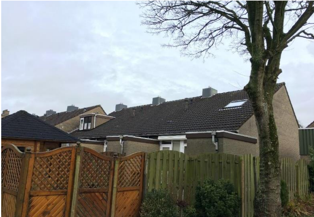
Figuur 8 Aan de achterzijde van de rijtjeswoningen zijn uitbouwen, dakkapellen en dakramen aanwezig.
