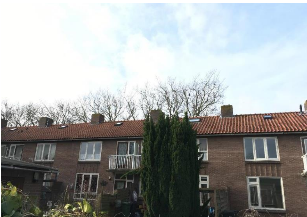
Figuur 23 Aan zowel de voor- als de achterzijde zijn siertuinen aanwezig.
