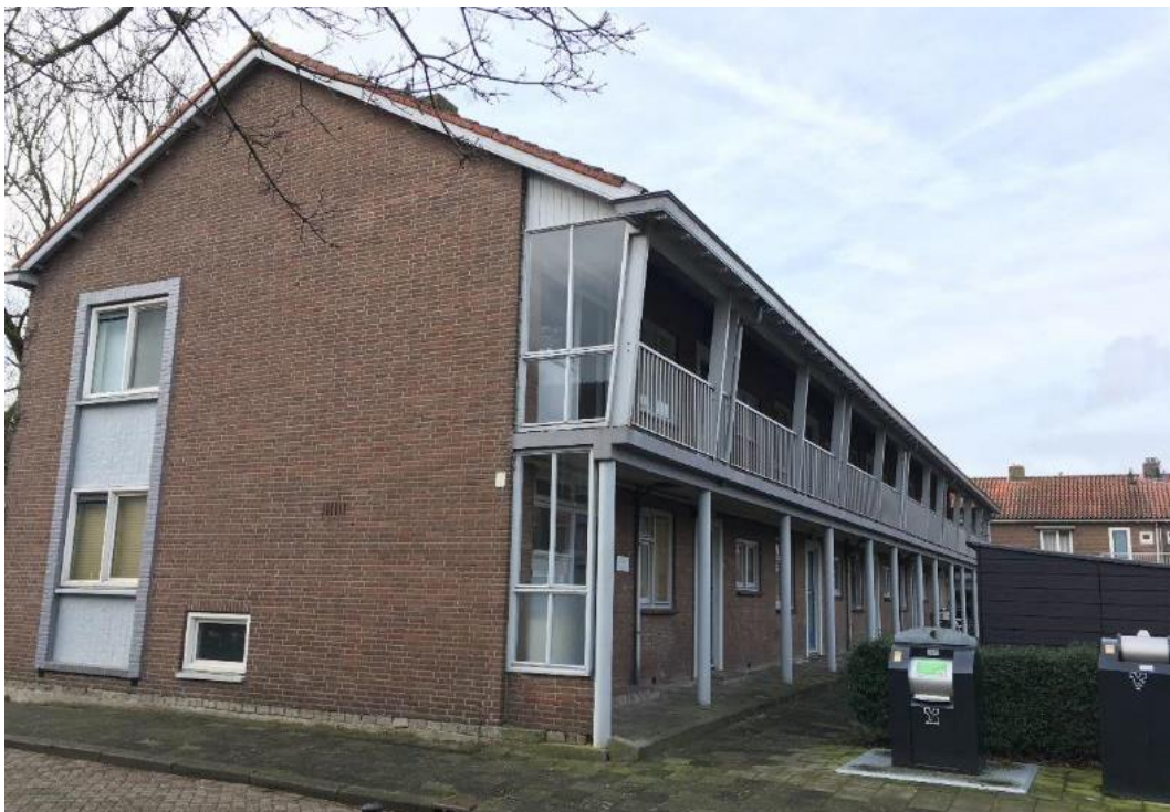
Figuur 19 Aan de achterzijde van de complexen zijn balkons aanwezig.
