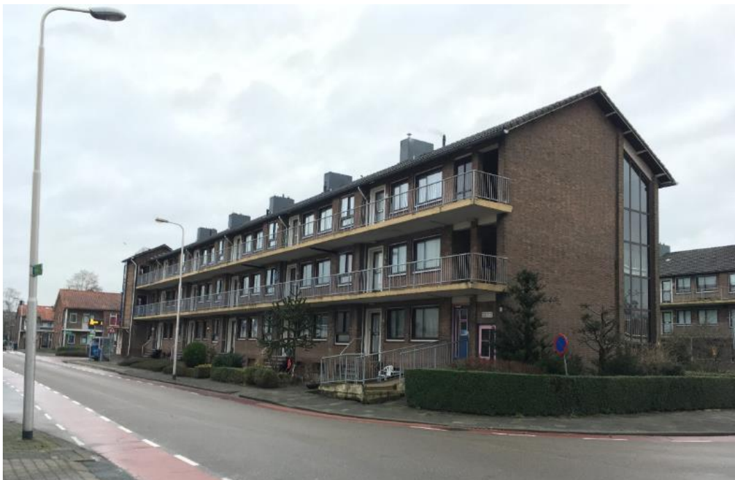
Figuur 4 De planlocatie aan het Raadhuisplein betreft een galerijflat bestaande uit 15 woningen.
