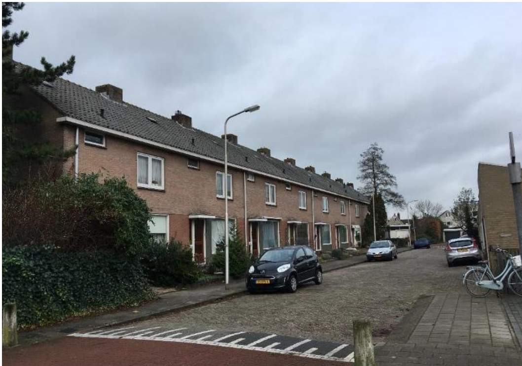
Figuur 10 De planlocatie aan de Merwestraat betreft een 6-tal rijtjeswoningen.
