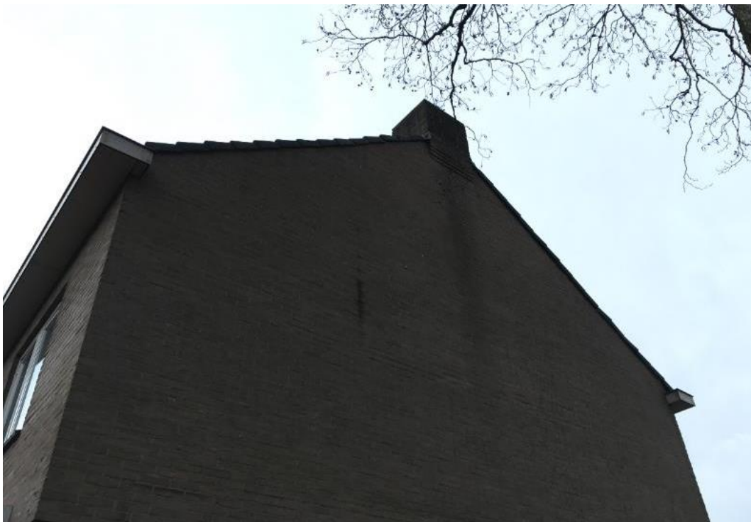
Figuur 11 De zijgevel van een van de rijtjeswoningen aan de Merwestraat.
