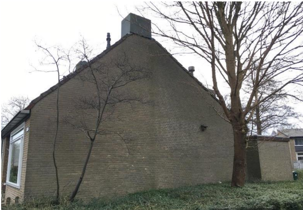
Figuur 7 Bij de zijgevels van de woonblokken zijn kantpannen en schoorsteenkappen met openingen aanwezig.
