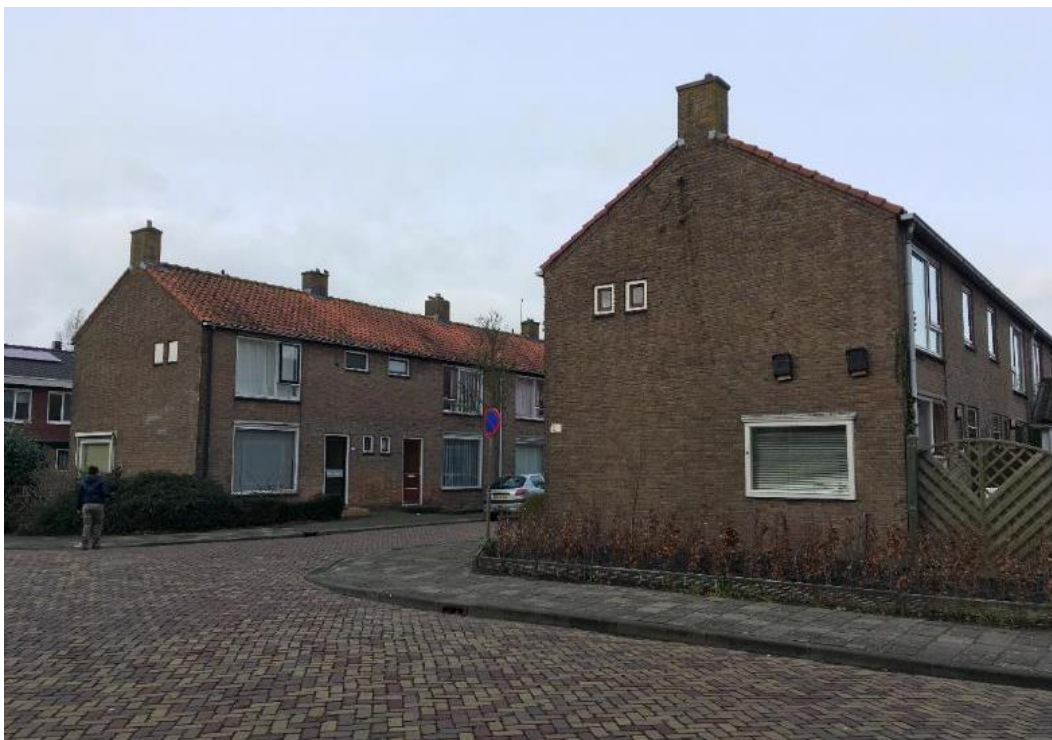
Figuur 29 Aan enkele van de zijgevels zijn vleermuiskasten bevestigd.
