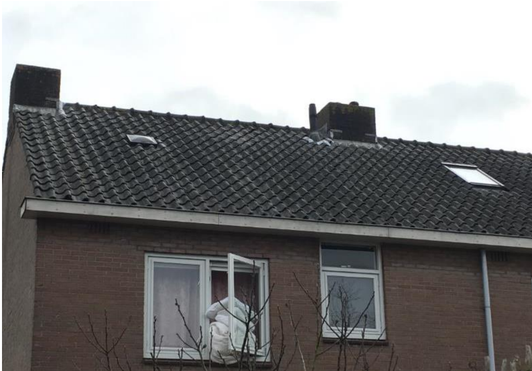
Figuur 12 De rijtjeswoningen aan de Merwestraat gezien vanaf de achterzijde.
